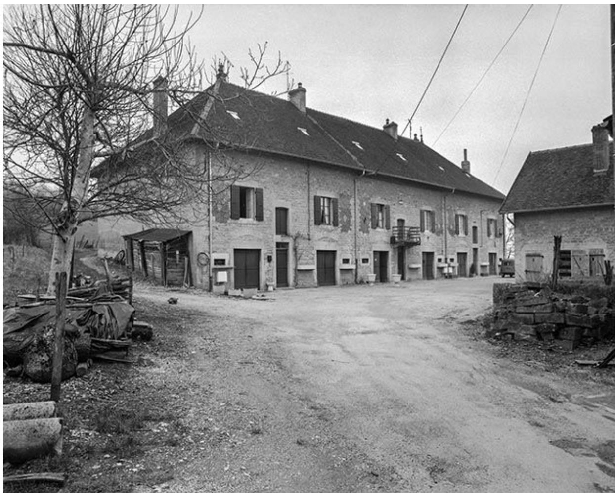
Maison située au lieudit Savagna.
