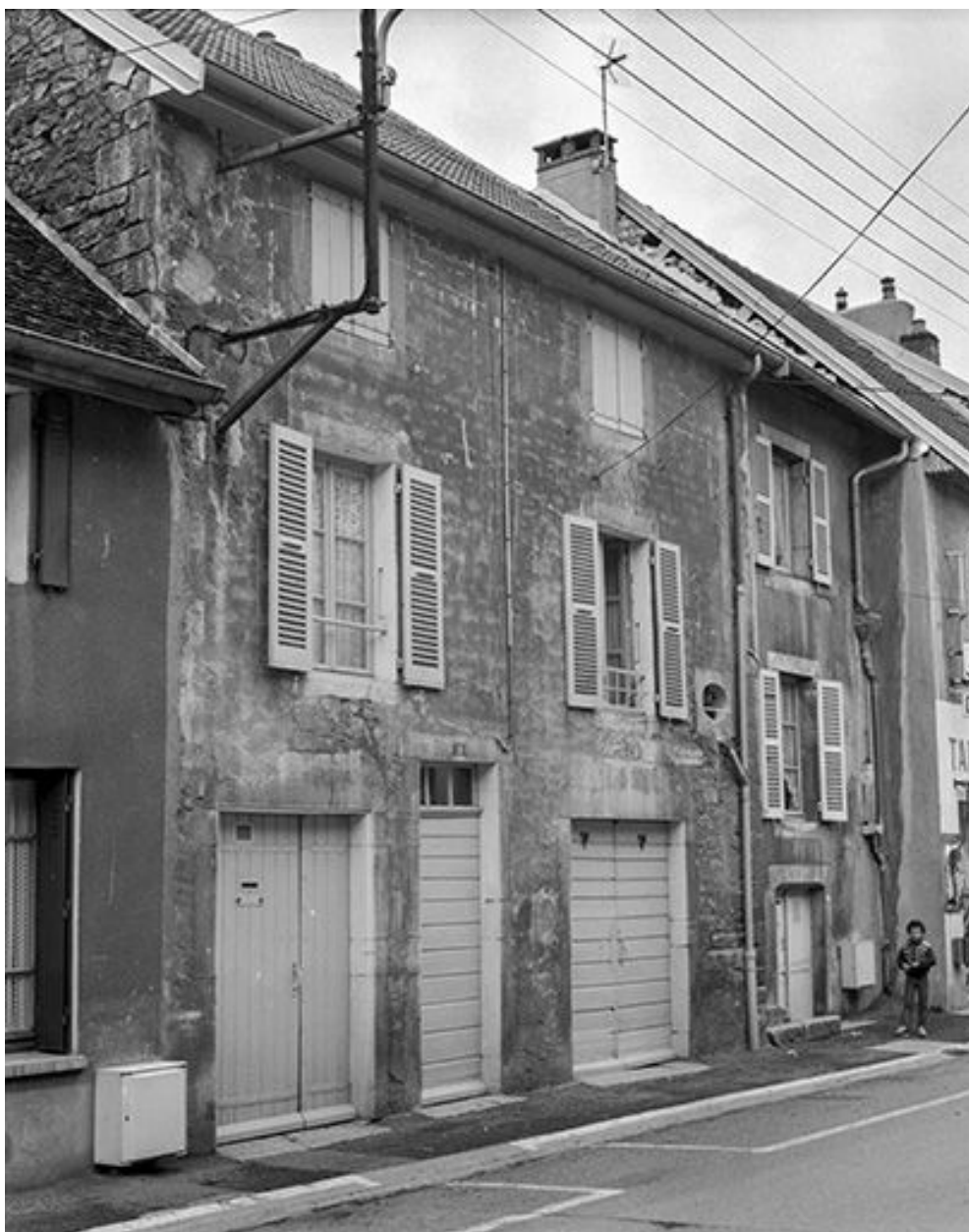
Maison située rue Jean-Jaurès.
