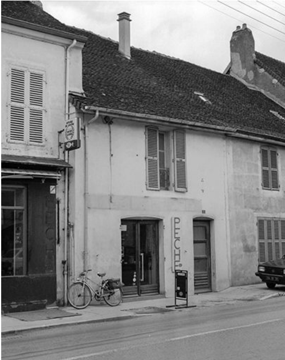
Maison située rue Aristide Briand.
