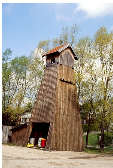
Saline : chevalement du puits n° 7 en 1994. Phot. Laurent Poupard IVR43_19943900241ZA
