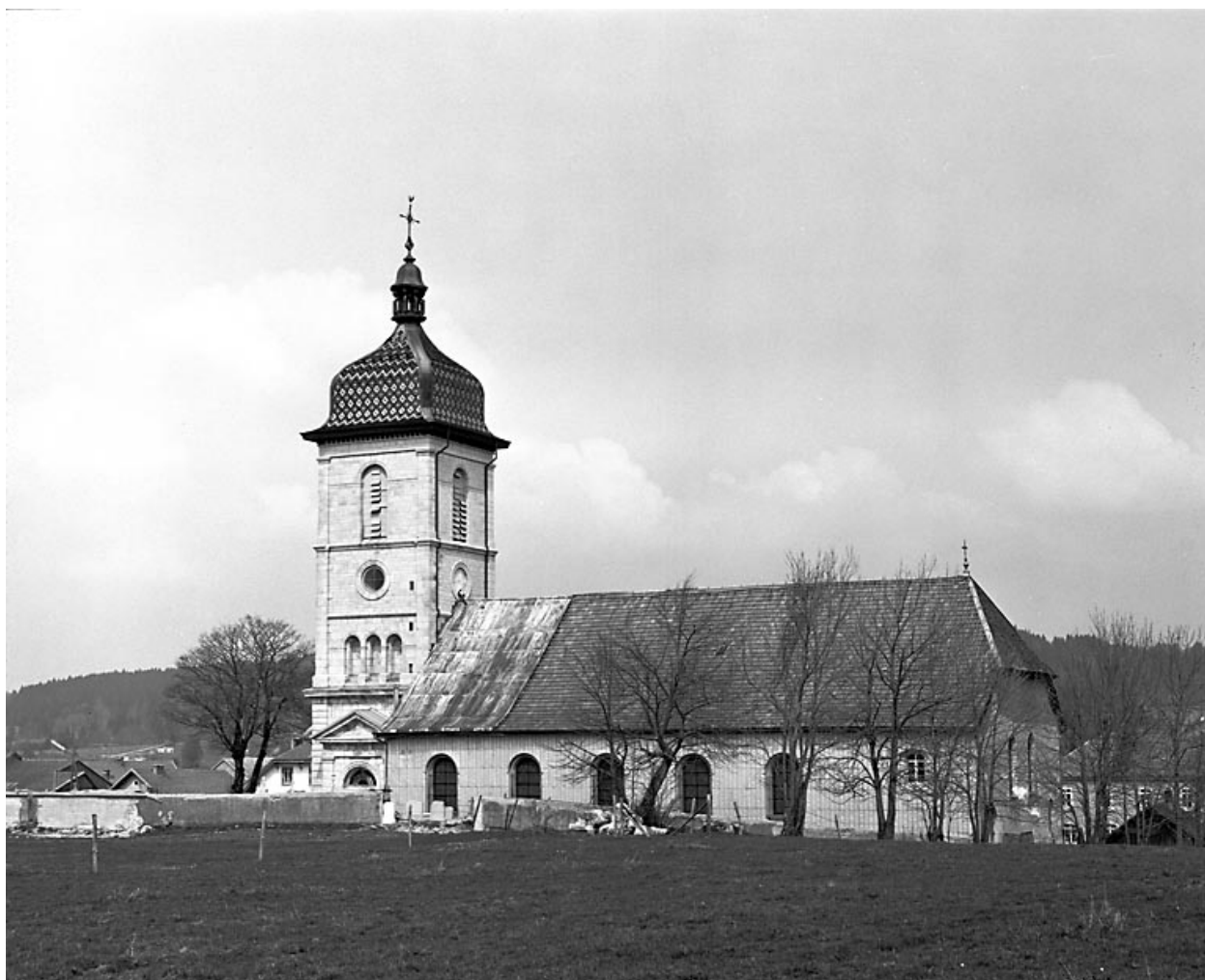
Vue de la façade sud.
