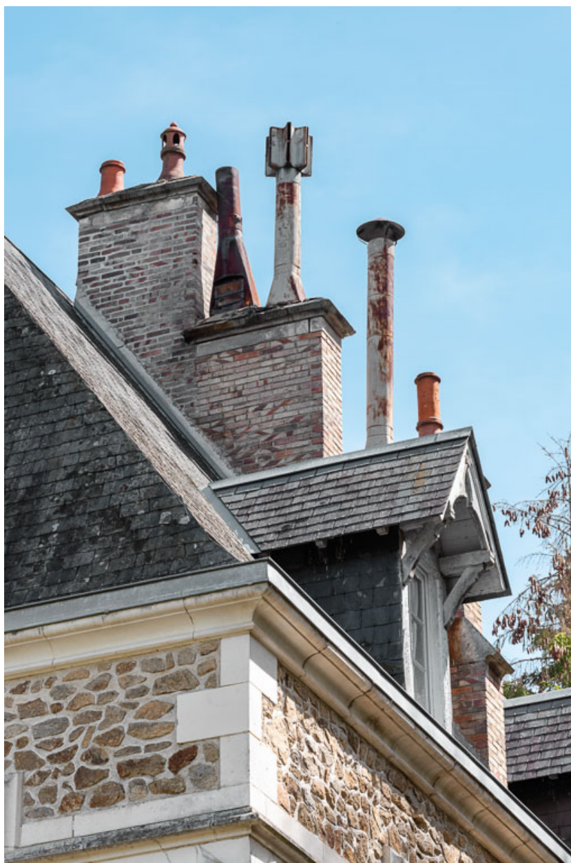
Couverture en ardoise, lucarnes et cheminées.
