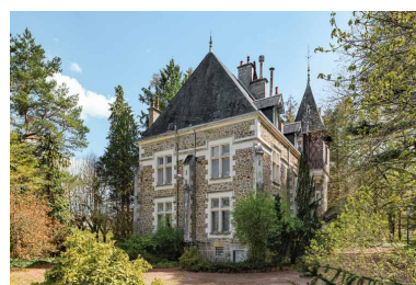
Façade nord-ouest. Phot. Pierre-Marie Barbe-Richaud IVR26_20195800043NUC4A
