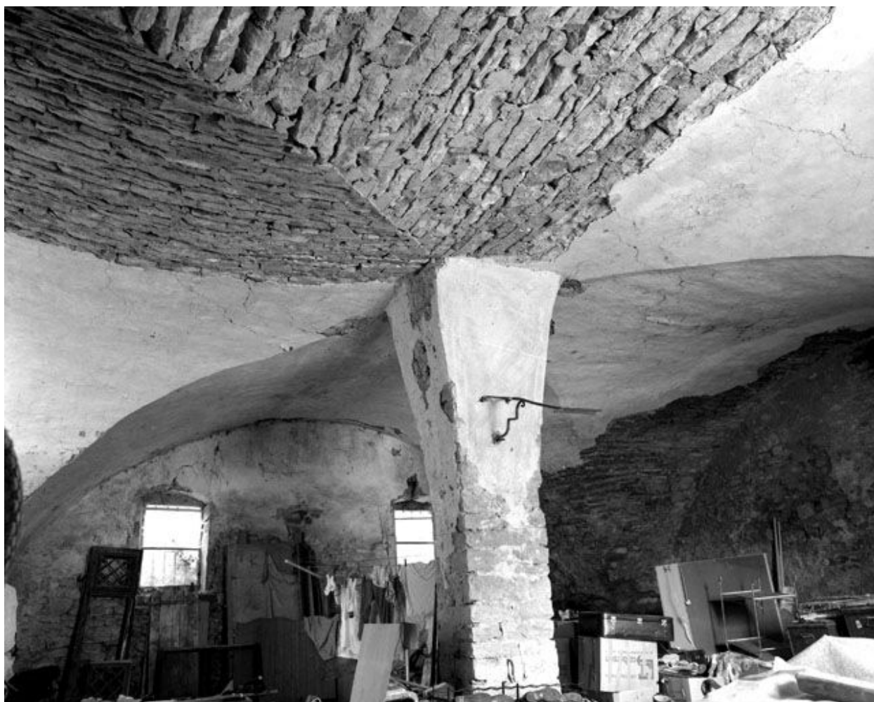
Pièce voûtée au rez-de-chaussée : la voûte.
