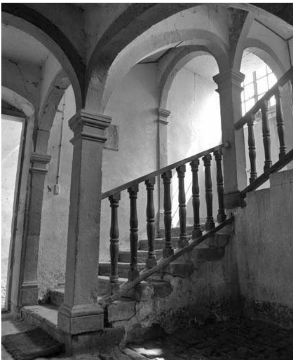
Escalier intérieur : première volée.
