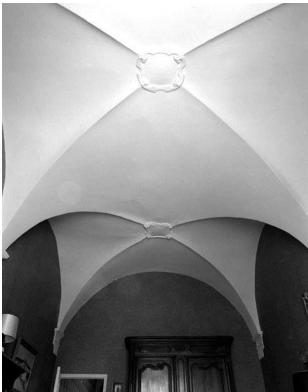
La voûte de la chapelle.
