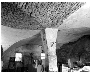
Pièce voûtée au rez-de-chaussée : la voûte. Phot. Yves Sancey IVR43_19843900400X
