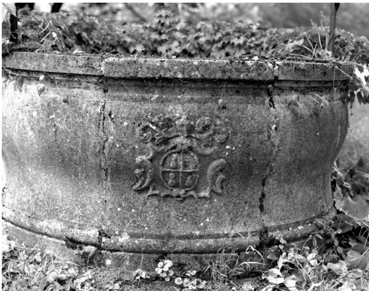
Blason sur la margelle du puits.
