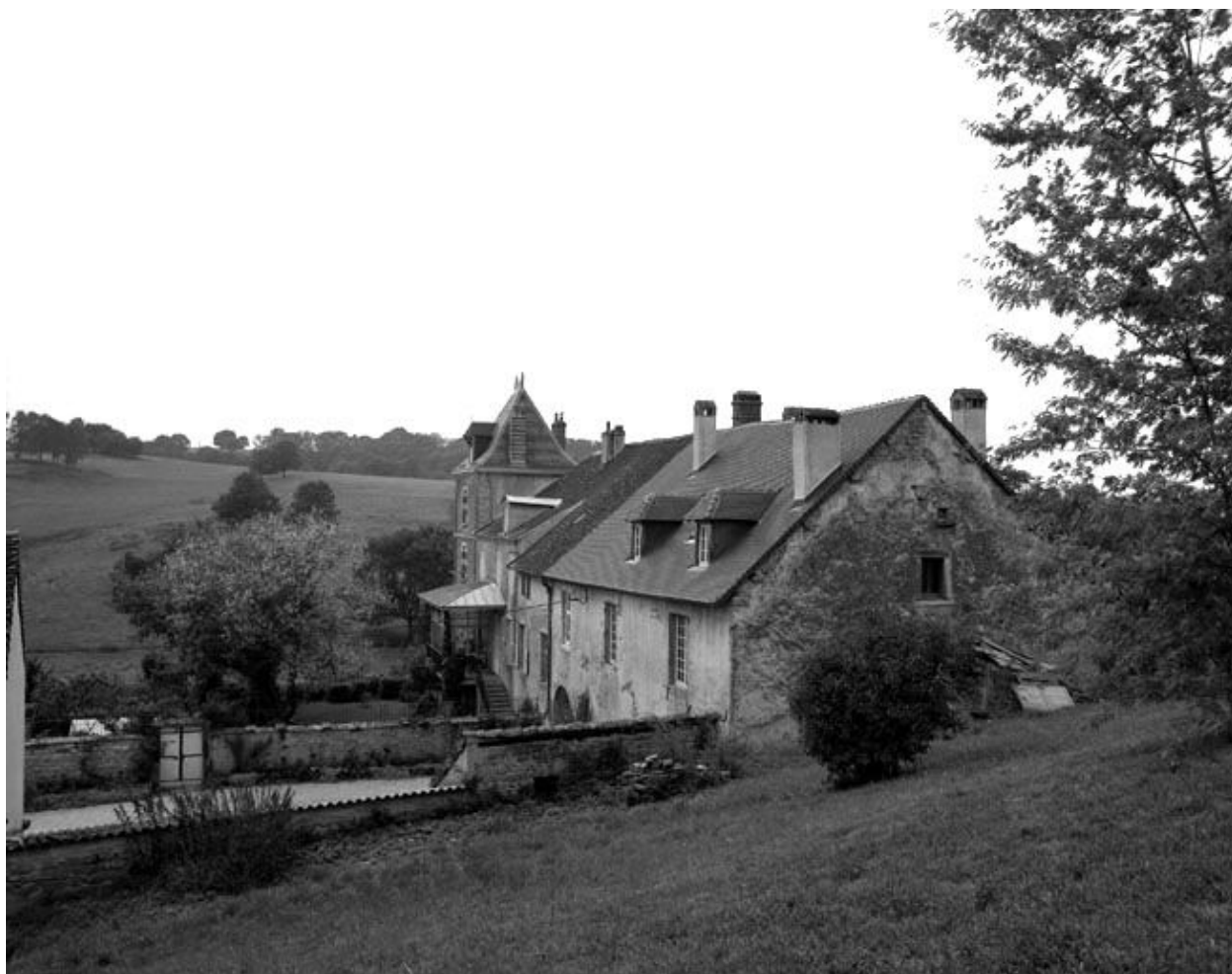
Vue générale depuis l'est.
