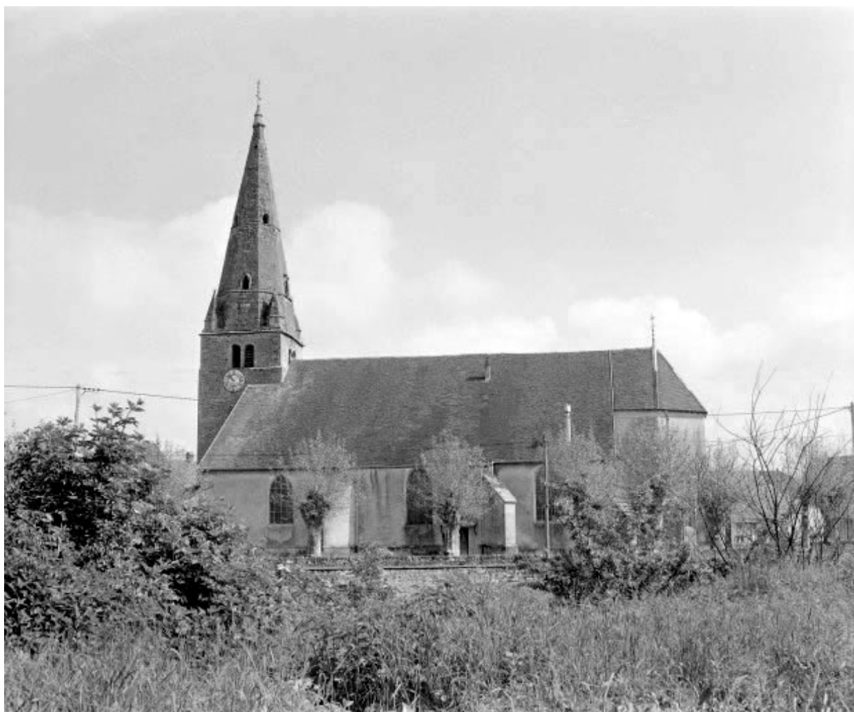
Façade latérale sud.
