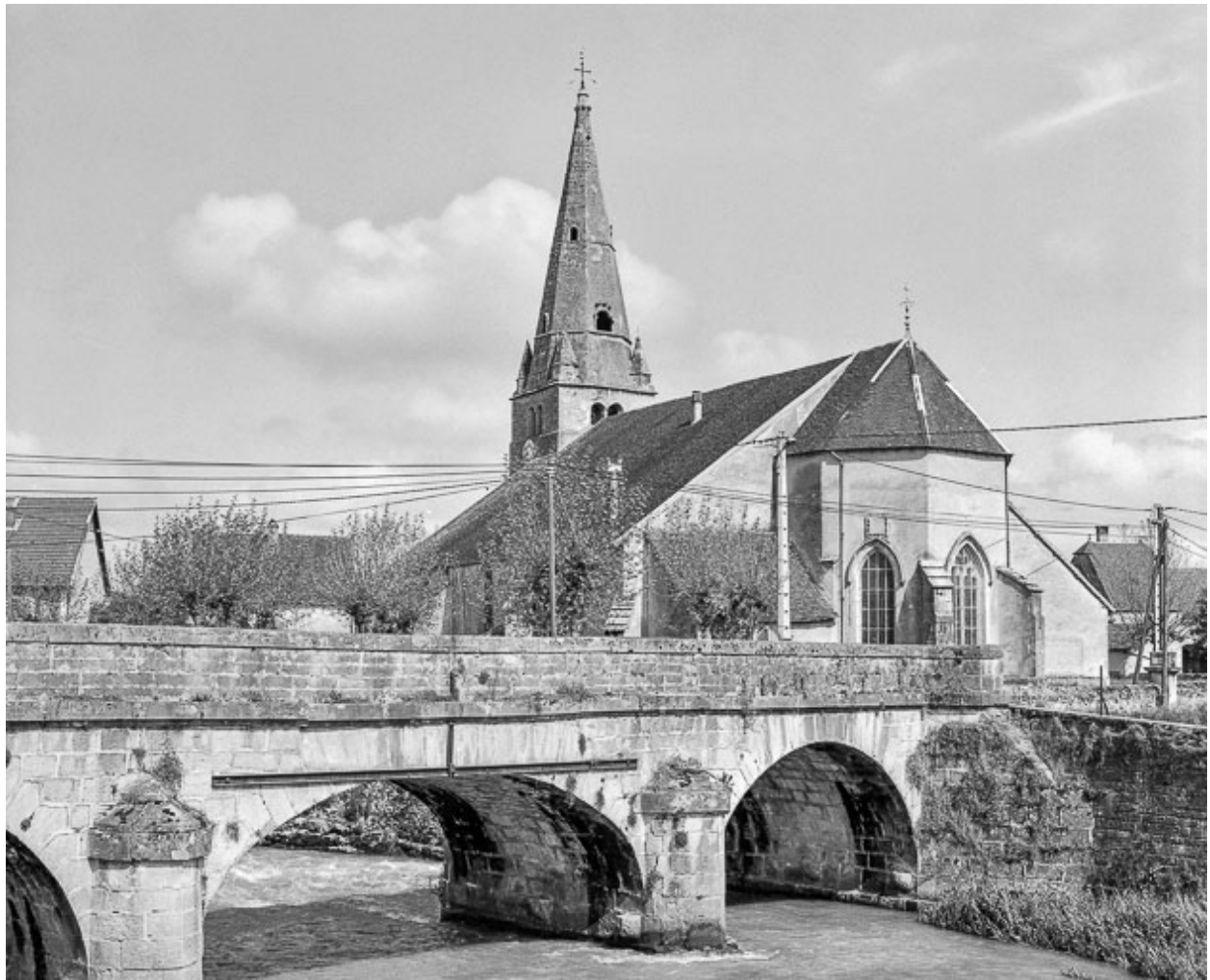
Façade latérale sud et abside.
