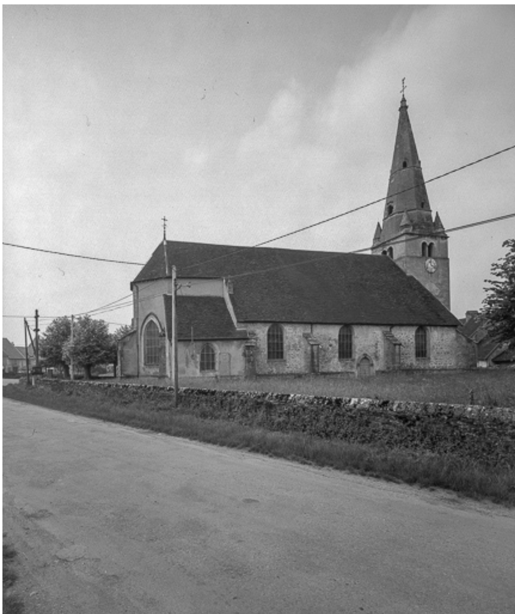
Façade latérale nord.
