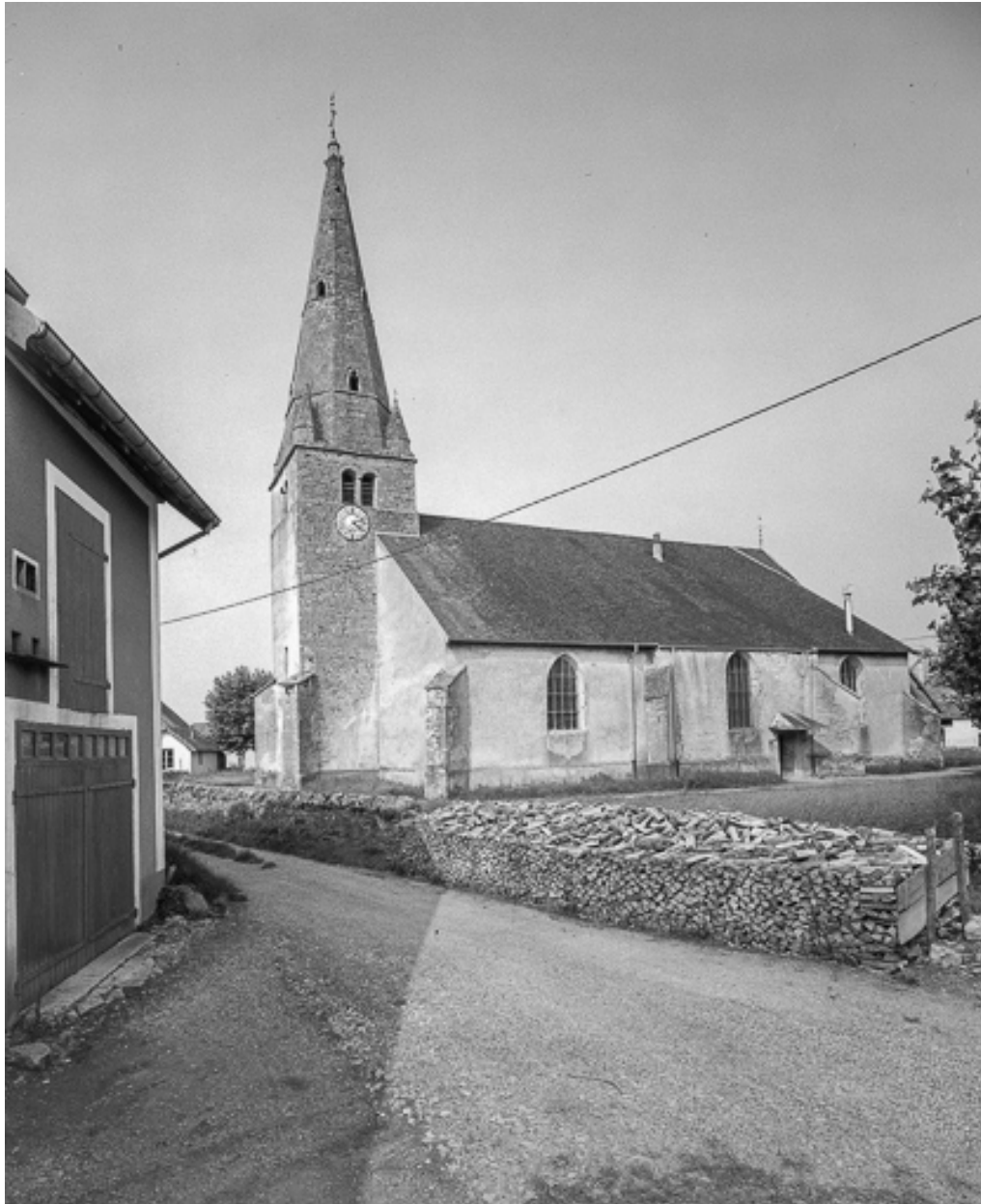
Façade latérale sud.
