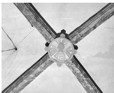
Troisième chapelle sud : clef de voûte. Phot. Yves Sancey IVR43_19753900877X
