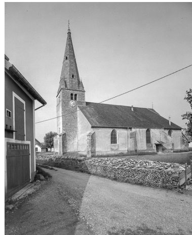
Façade latérale sud. Phot. Yves Sancey IVR43_19753900865V
