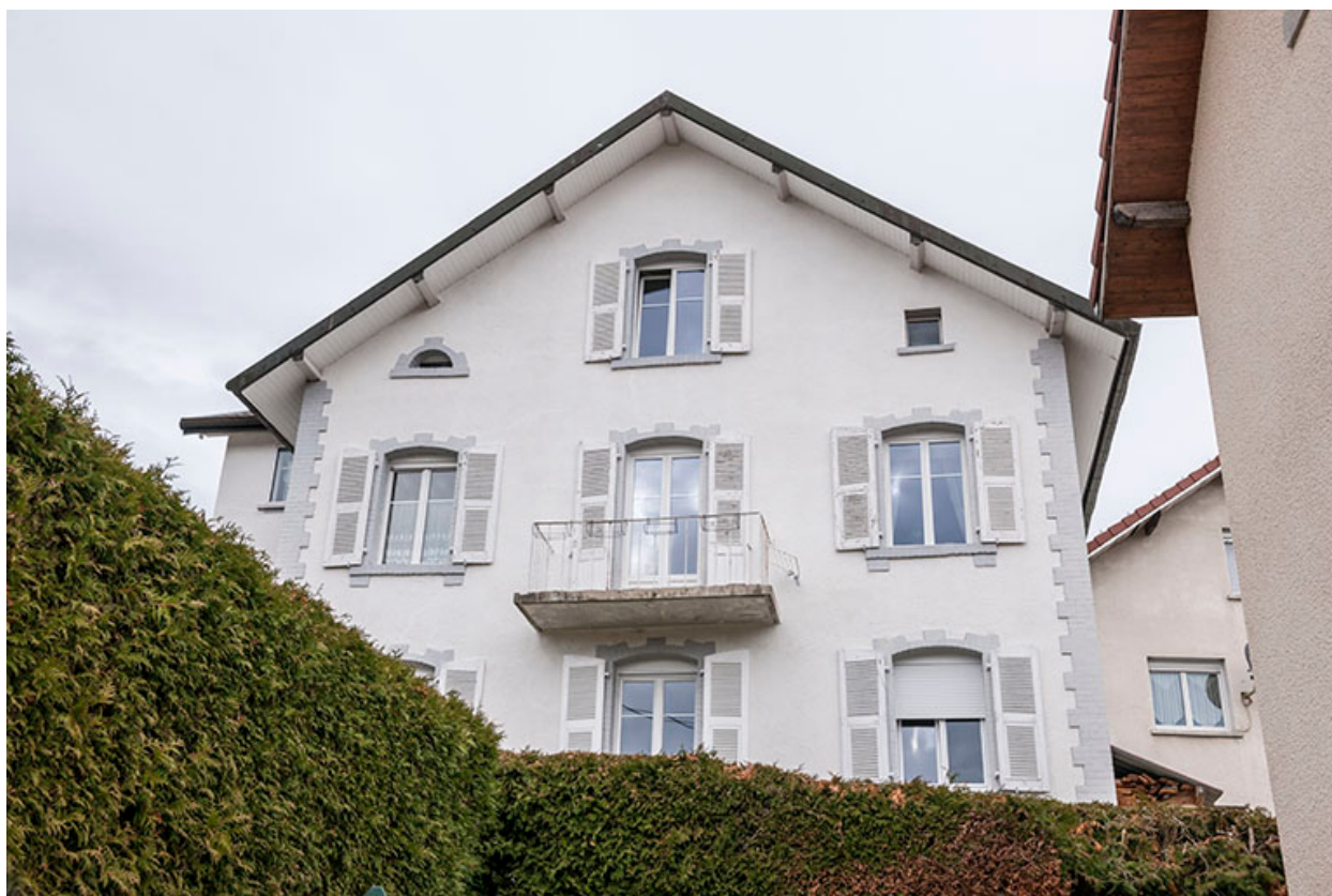
Façade latérale droite, vue en contre-plongée.
