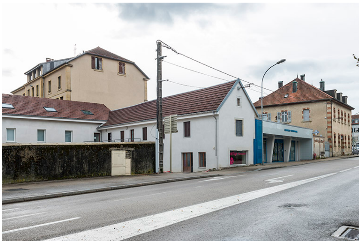
Vue d'ensemble depuis la rue du Mont.
