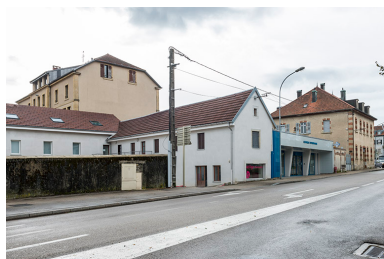
Vue d'ensemble depuis la rue du Mont.
