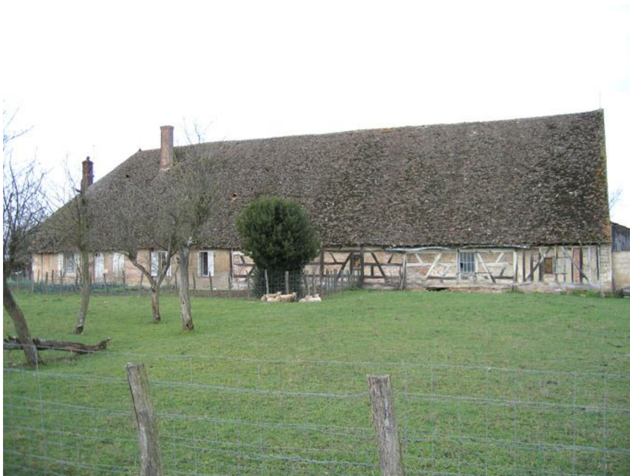
Vue d'ensemble de la façade.
