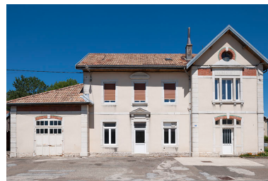
Façade antérieure. Phot. Jérôme Mongreville
