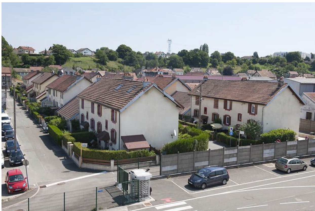
Vue plongeante depuis l'ouest.
