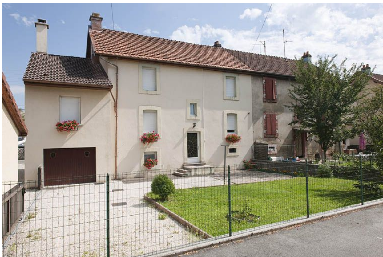
Rue de Verdun. Façade postérieure d'une habitation.
