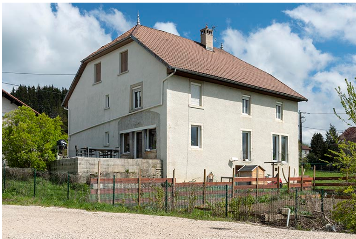
Façades postérieure et latérale droite.
