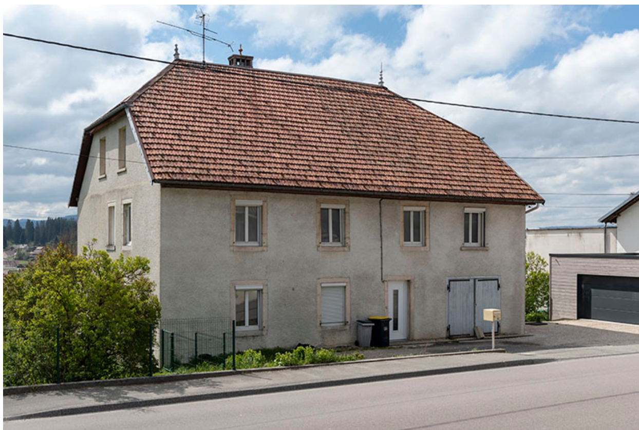
Façades antérieure et latérale gauche.
