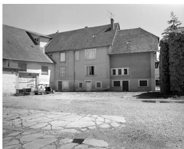
Façade postérieure du logement. Phot. Jérôme Mongreville IVR43_19963900422X
