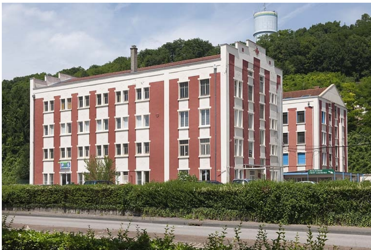
Immeuble de dortoirs. Vue depuis la route.
