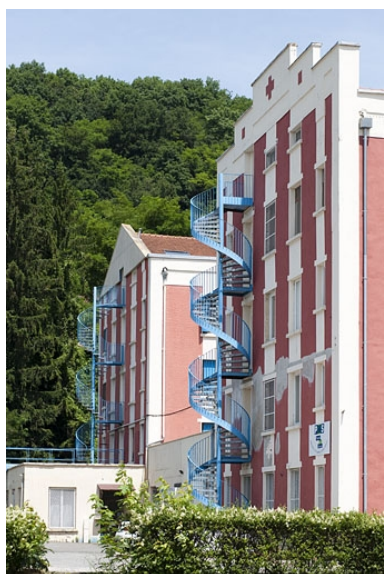
Immeubles de dortoirs. Pignons ouest.
