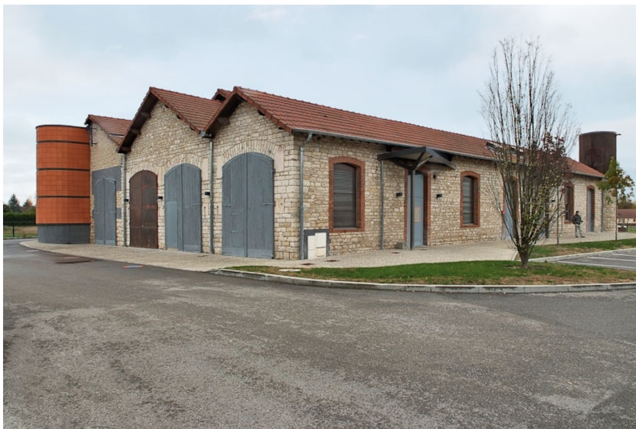
Vue d'ensemble du bâtiment.
