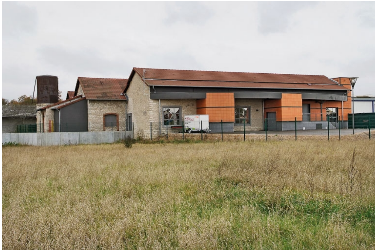
Vue d'ensemble du bâtiment.
