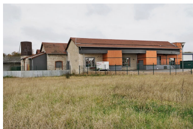
Vue d'ensemble du bâtiment.
