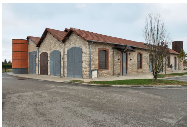
Vue d'ensemble du bâtiment.
