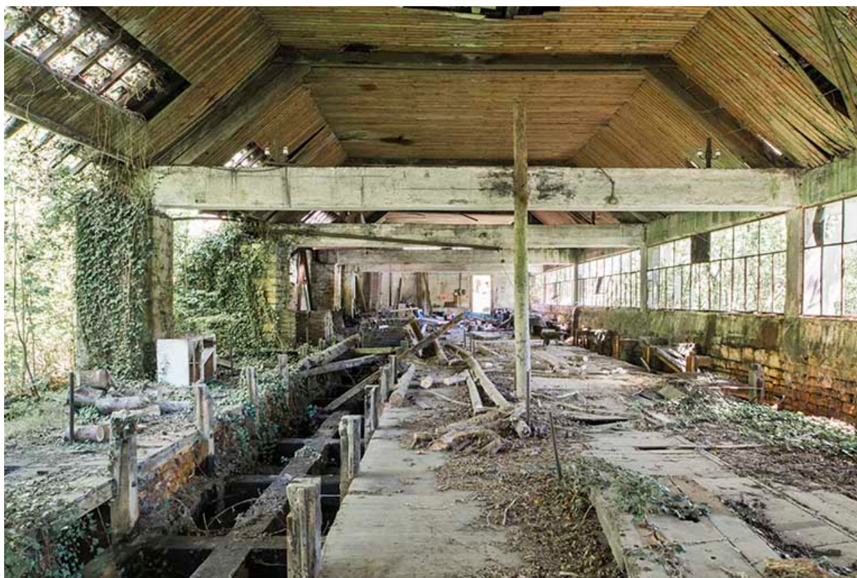
Atelier de tréfilerie. Vue intérieure depuis l'ouest.
