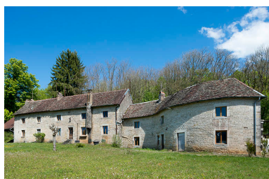
Logement ouvrier. Aile nord. Phot. Jérôme Mongreville IVR43_20172500634NUC4A
