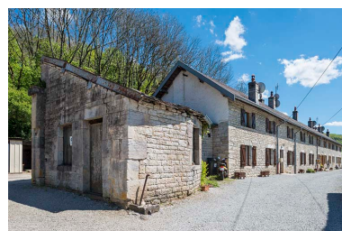
Logement ouvrier (aile sud). Phot. Jérôme Mongreville IVR43_20172500626NUC4A
