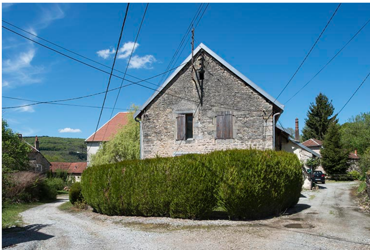
Moulin et logements depuis le sud-est.
