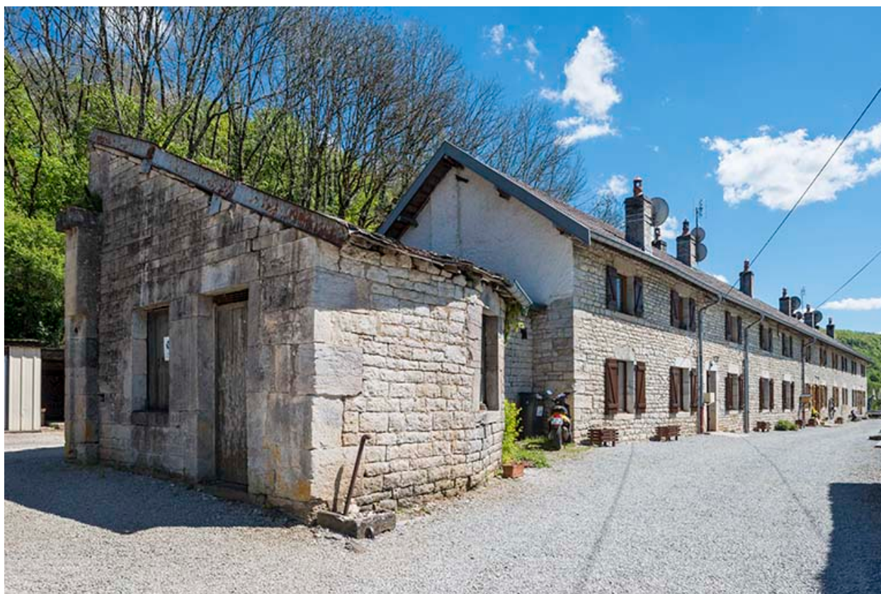
Logement ouvrier (aile sud).
