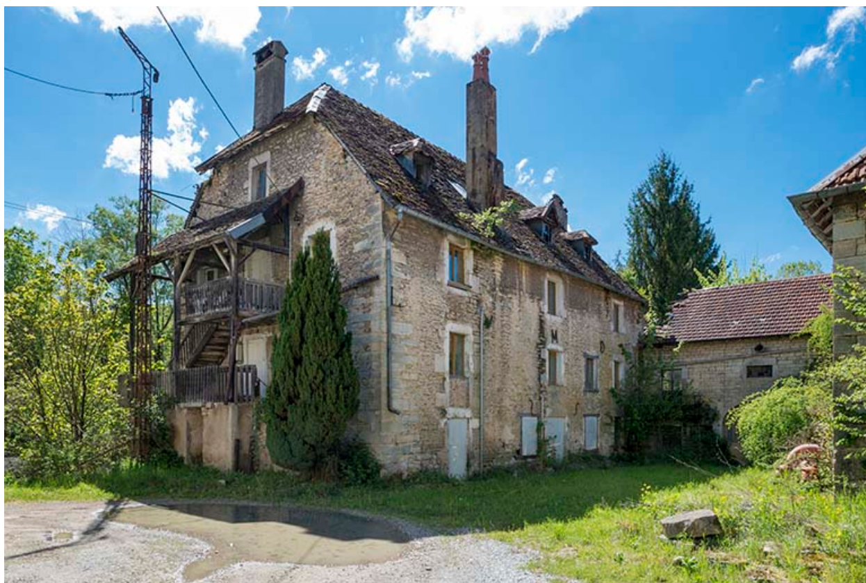
Bâtiment du moulin (puis logement ouvrier).
