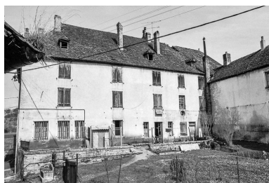
Logement ouvrier, bureau et dispensaire en 1979. Phot. J. Dumont IVR43_19792501155Z
