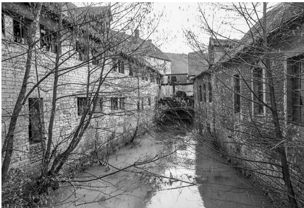
Bief de dérivation entre les ateliers en 1979.
