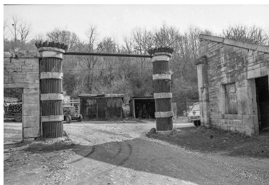
Portail de l'usine, depuis la cour, en 1979. Phot. J. Dumont IVR43_19792501148Z
