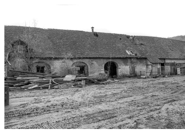
Bâtiments industriels sur l'île en 1979.
