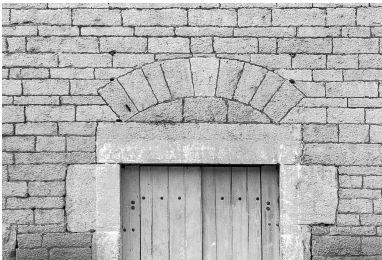
Logement ouvrier. Détail de la façade (1979).
