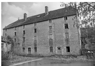
Logement ouvrier. Façade ouest en 1979. Phot. J. Dumont IVR43_19792501159Z
