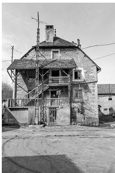
Mur-pignon du moulin (converti en logement ouvrier) en 1979.
