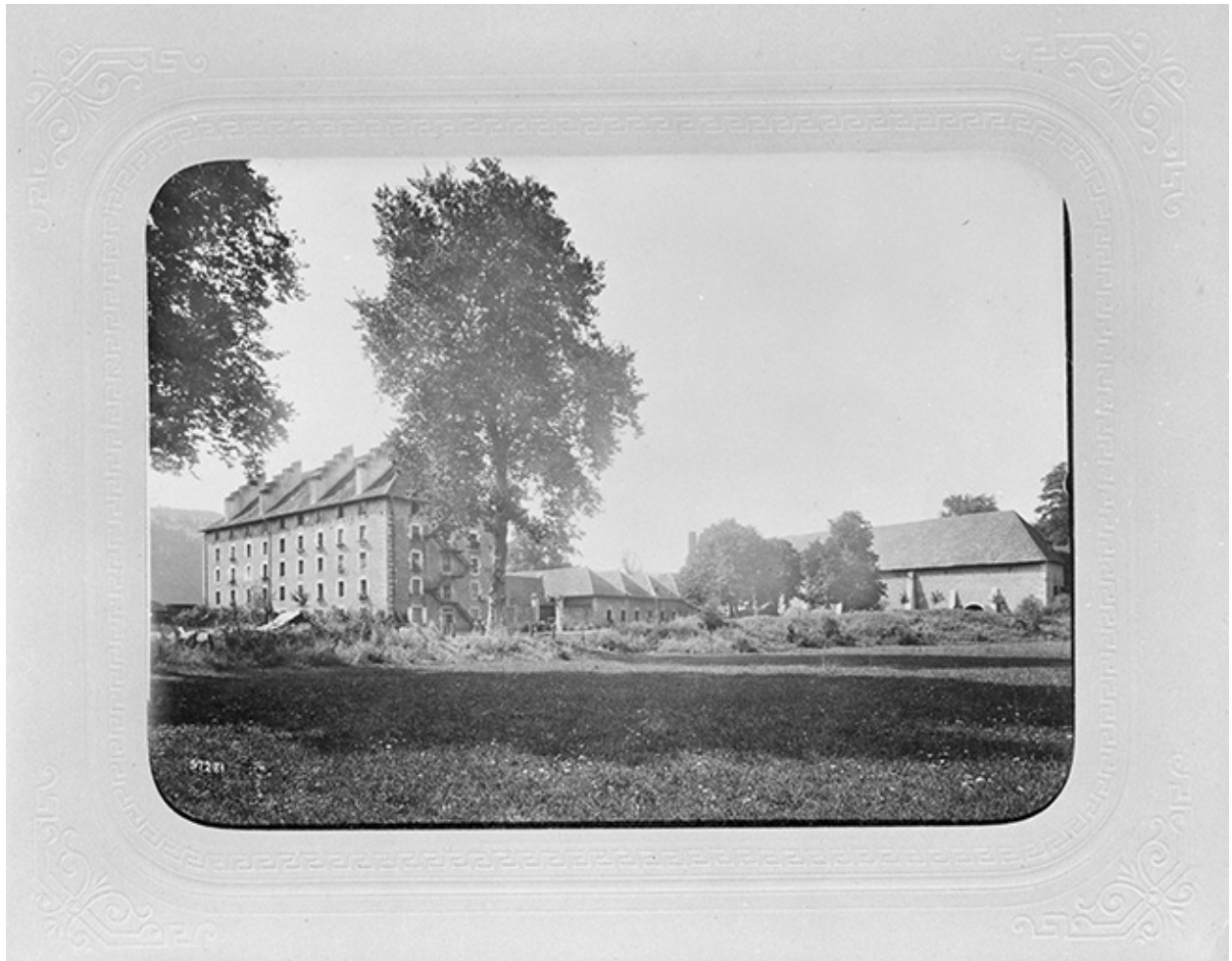
Usine de Buillon, 1899-1900.
