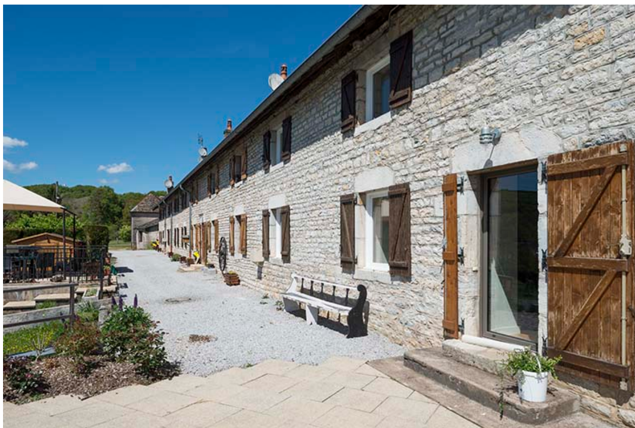
Logement ouvrier. Façade antérieure de l'aile sud.
