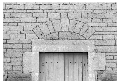
Logement ouvrier. Détail de la façade (1979). Phot. J. Dumont IVR43_19792501151Z
