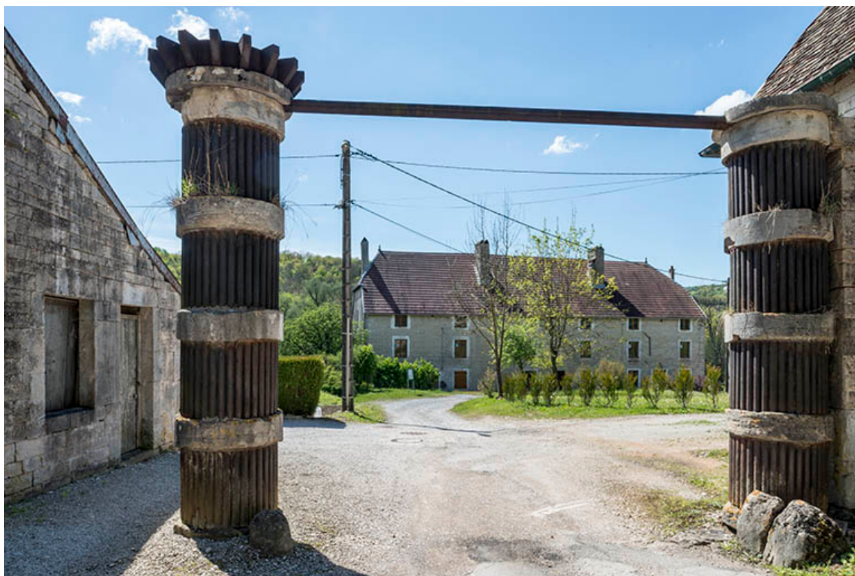
Portique d'entrée. Piliers fasciculés (pierre et fonte).
