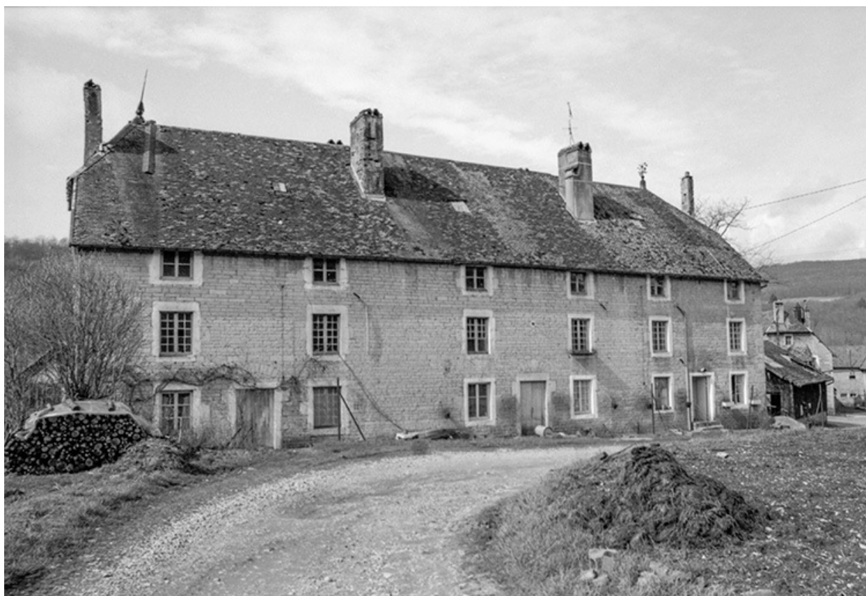
Logement ouvrier. Façade antérieure (est) en 1979.
