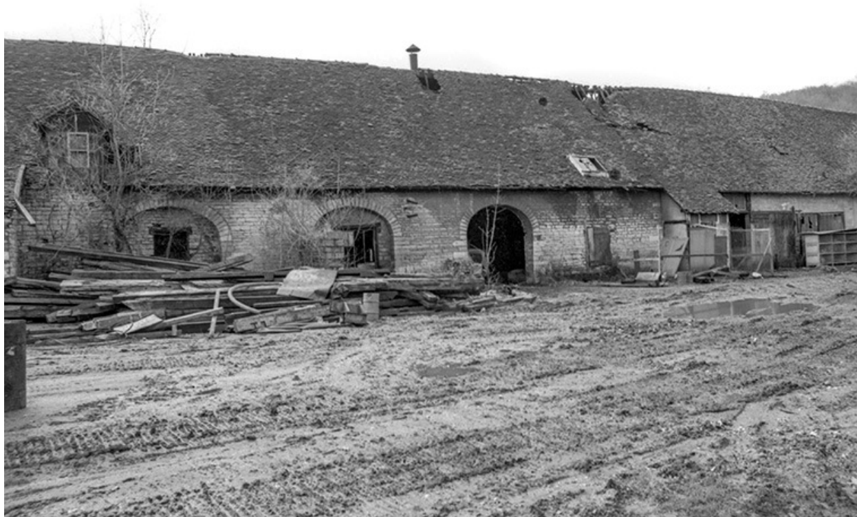
Bâtiments industriels sur l'île en 1979.
