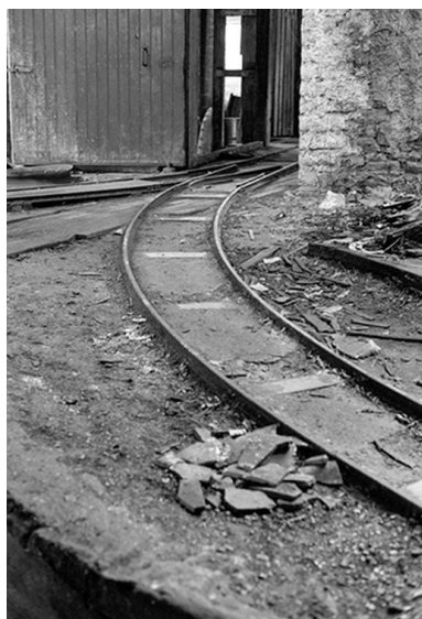
Voie Decauville à l'entrée d'un atelier en 1979.
