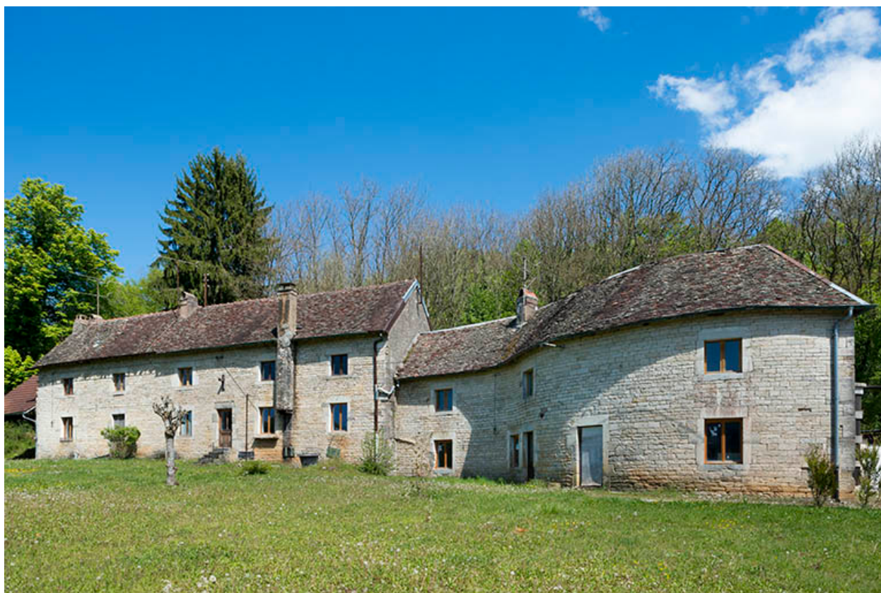
Logement ouvrier. Aile nord.
