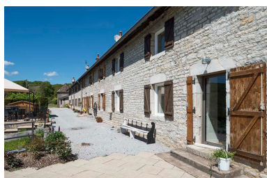
Logement ouvrier. Façade antérieure de l'aile sud. Phot. Jérôme Mongreville IVR43_20172500628NUC4A
