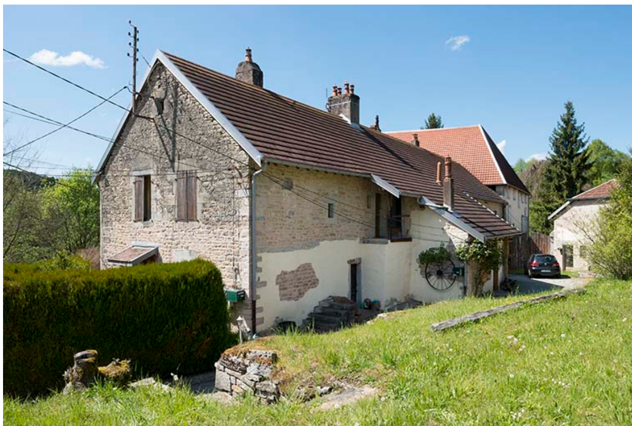
Logement patronal (maison du maître de forges).
