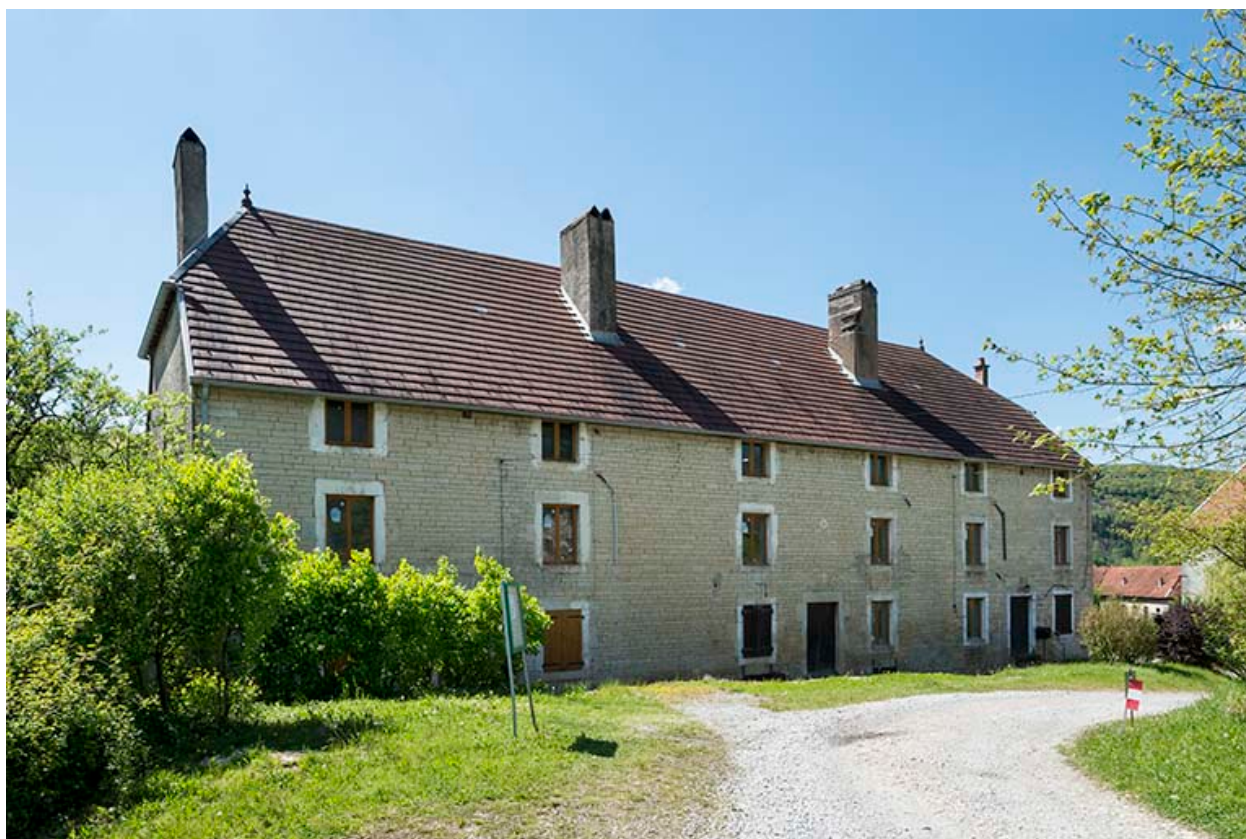
Logement ouvrier ouest. Façade sur cour.
