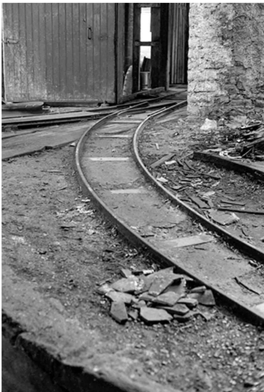
Voie Decauville à l'entrée d'un atelier en 1979.
