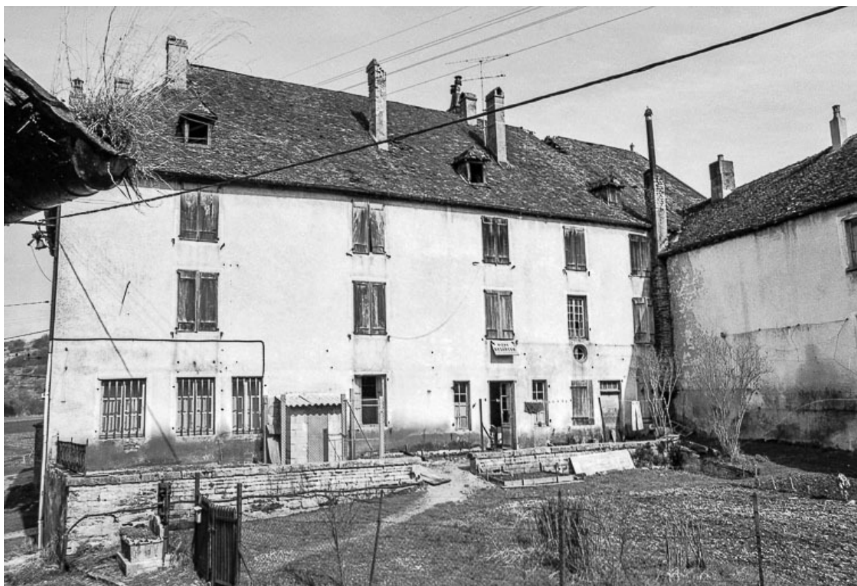
Logement ouvrier, bureau et dispensaire en 1979.
