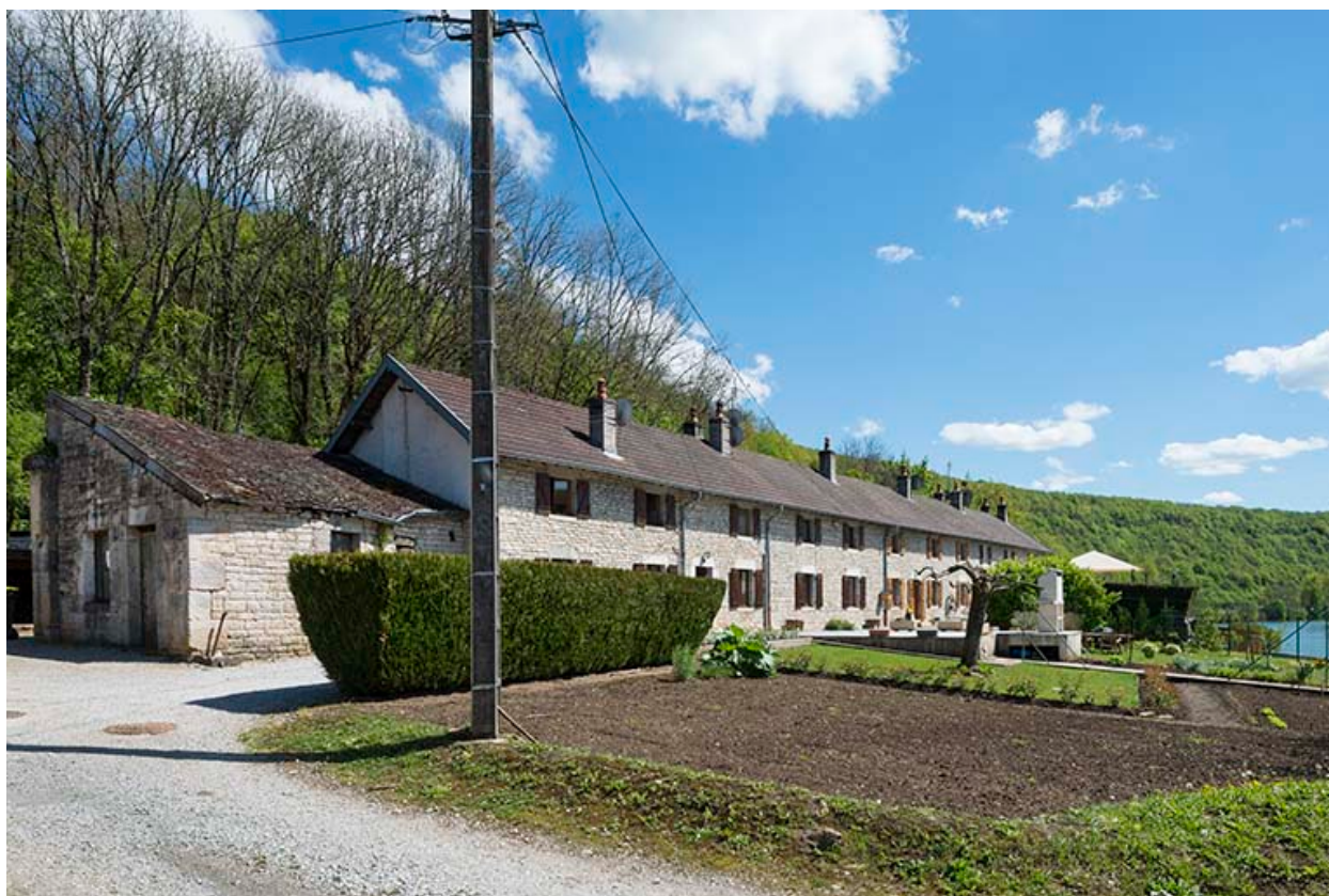
Logement ouvrier sud. Vue de trois quarts.
