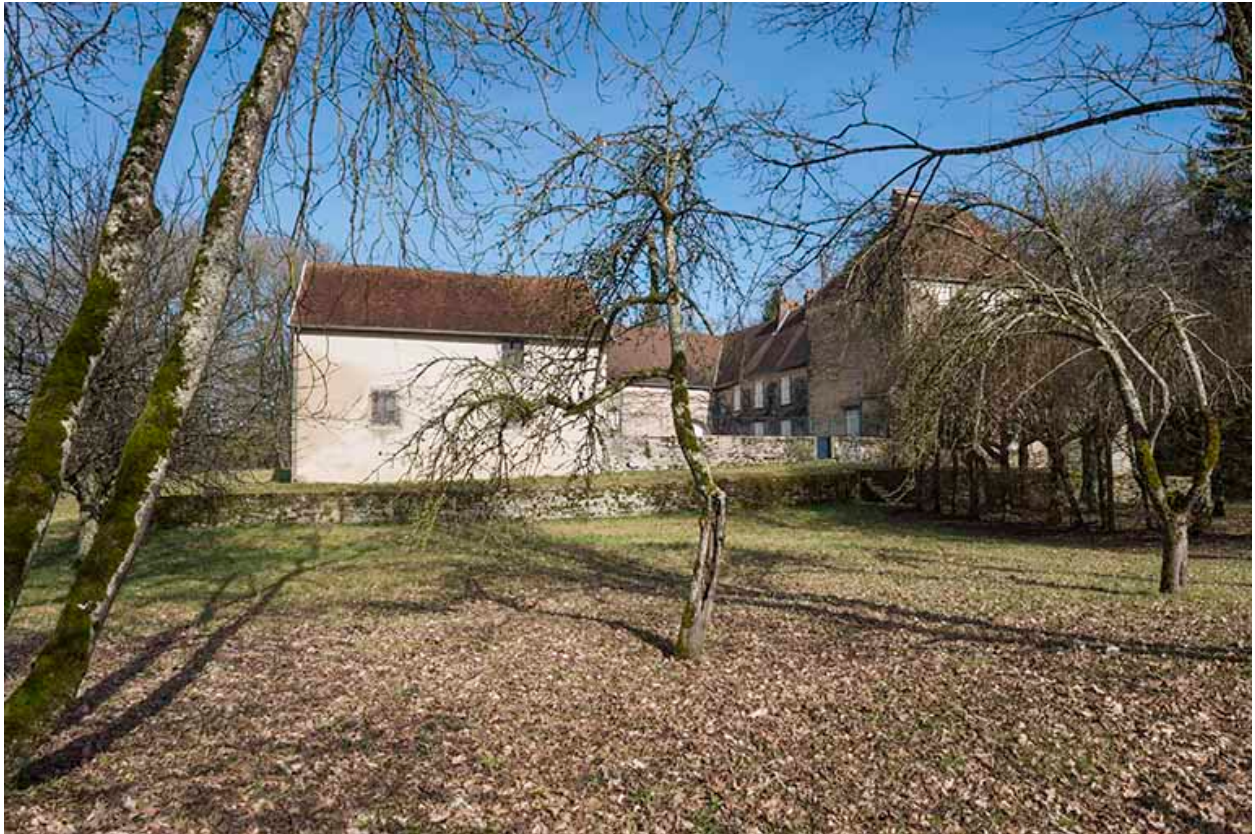
Vue Sud du château.
