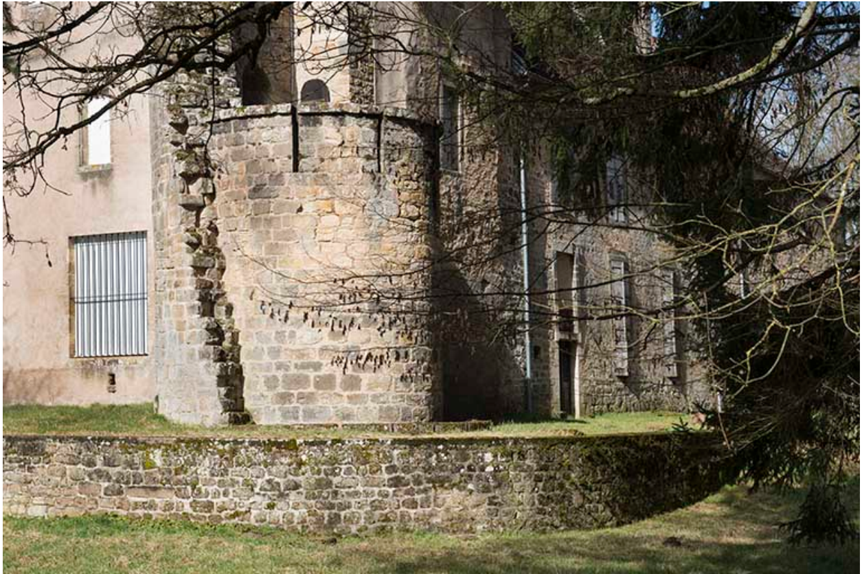
Détail sur la maçonnerie de la tour.
