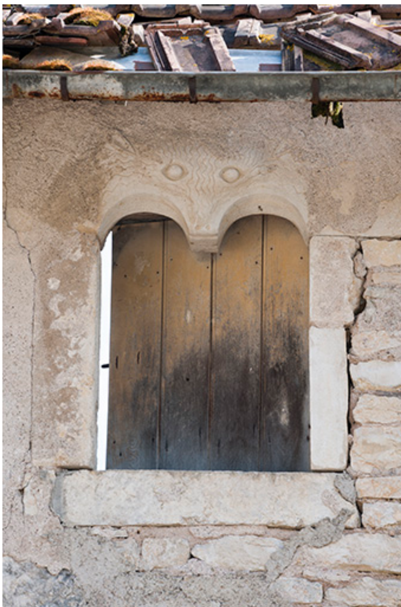
Détail d'une fenêtre du premier étage.
