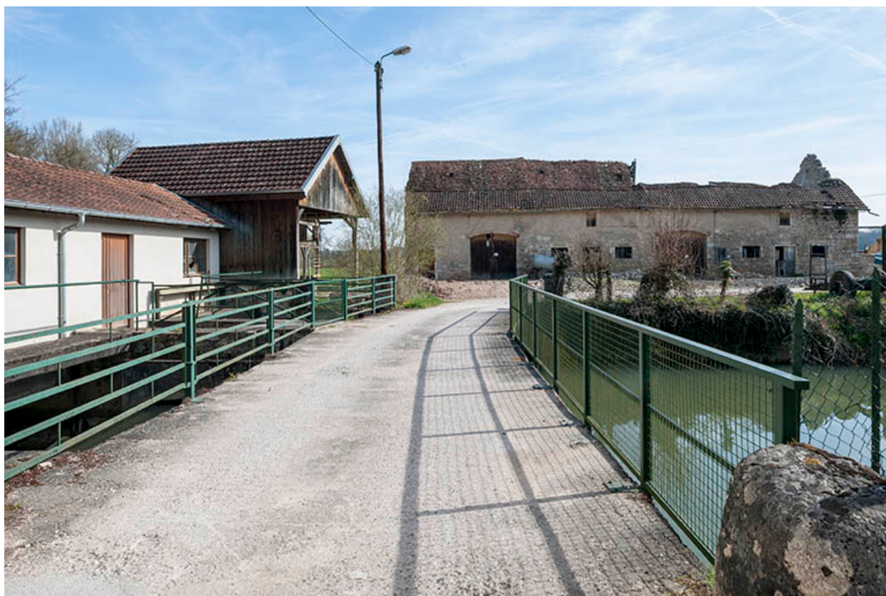
Centrale hydroélectrique (à gauche) et bâtiment agricole.
