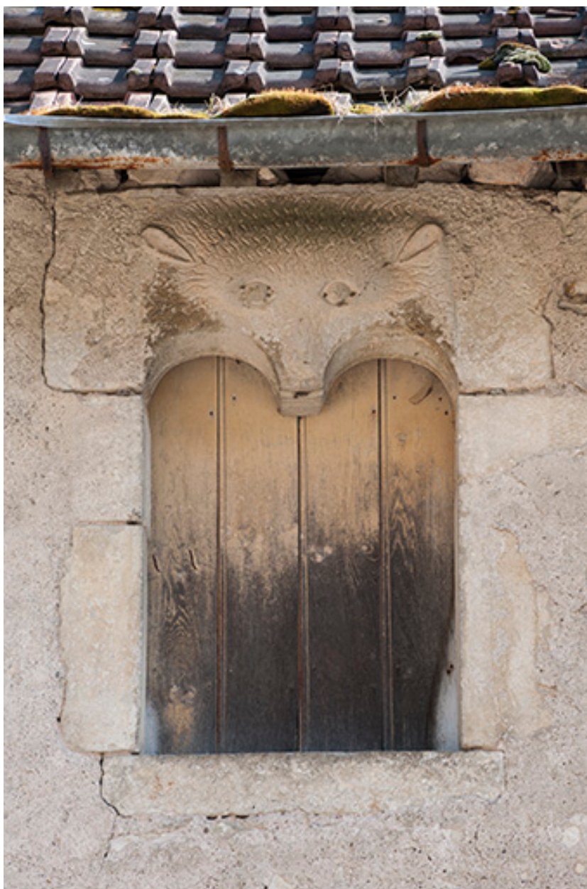
Détail d'une fenêtre du premier étage.
