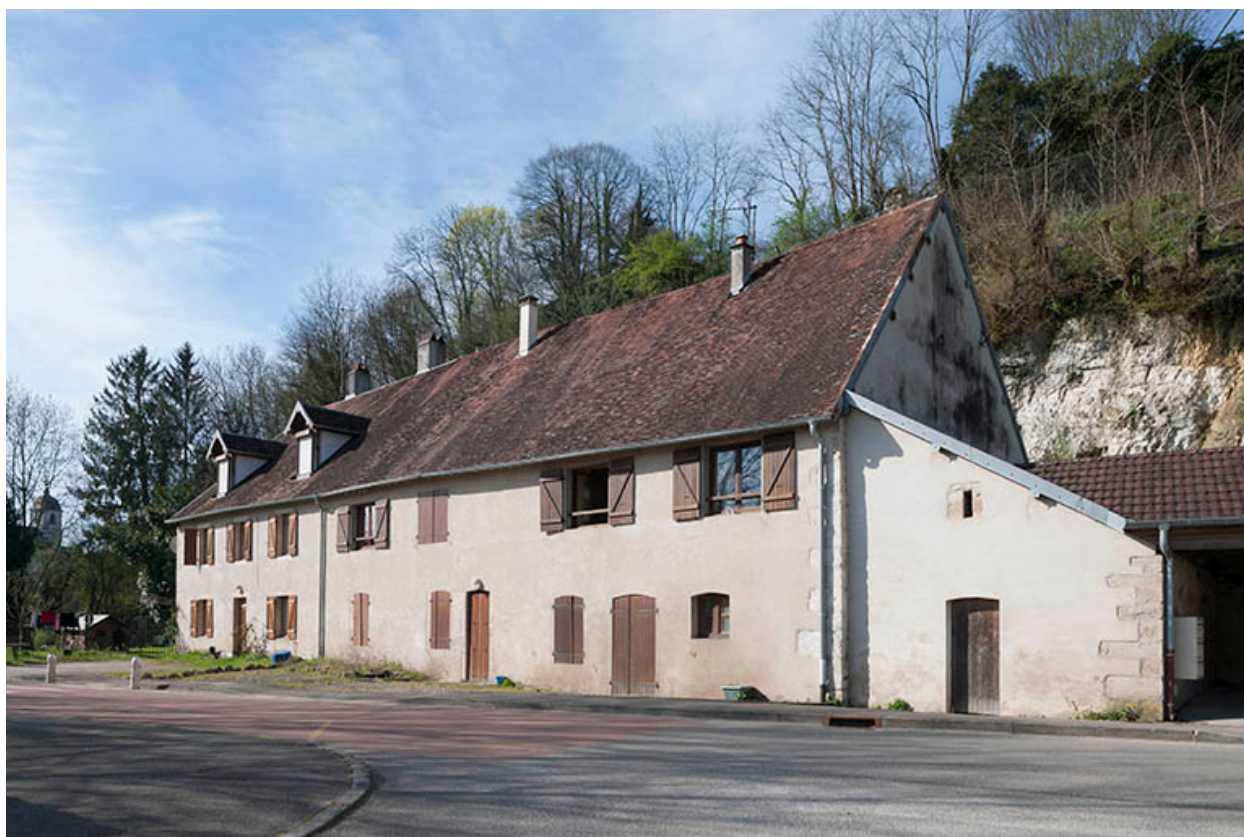
Logement ouvrier (11-13 route d'Emagny).
