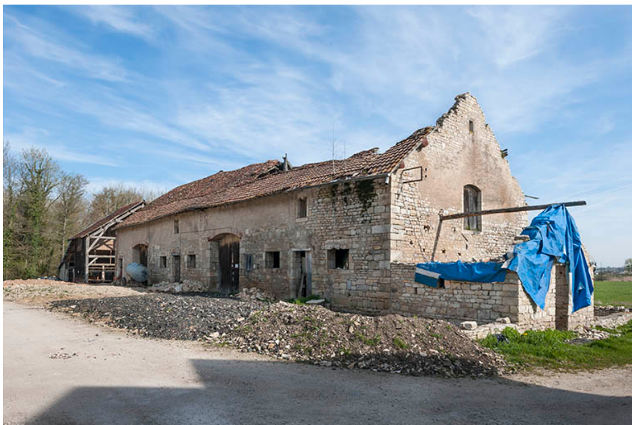
Bâtiment agricole vu de trois quarts droite.
