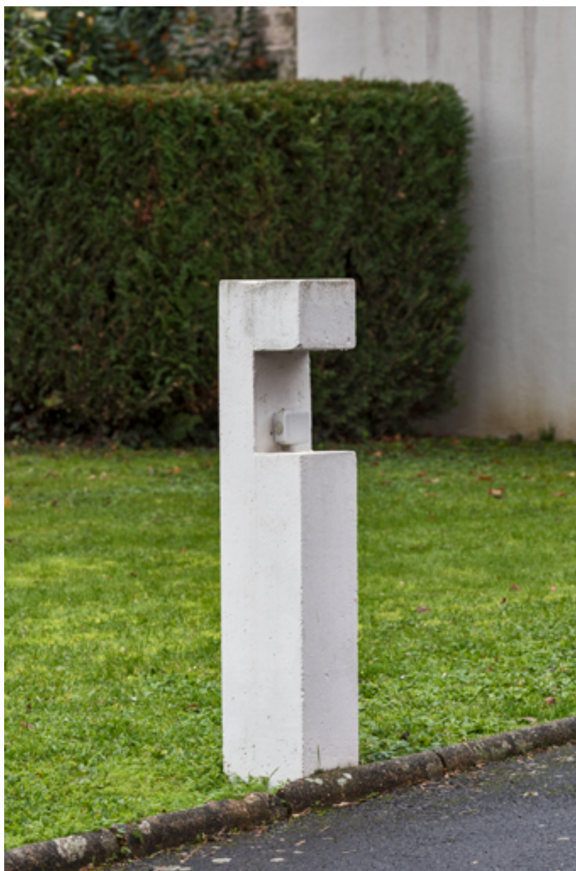
Détail d'une borne lumineuse.
