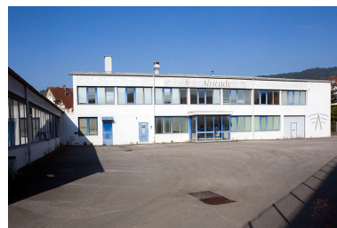
Bâtiment à étage : façade orientale. Phot. Yves Sancey IVR43_20132502116NUC2A
