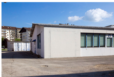
Bâtiment en rez-de-chaussée : extrémité occidentale. Phot. Yves Sancey IVR43_20132502114NUC2A
