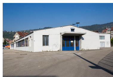
Bâtiment en rez-de-chaussée : extrémité orientale. Phot. Yves Sancey IVR43_20132502115NUC2A
