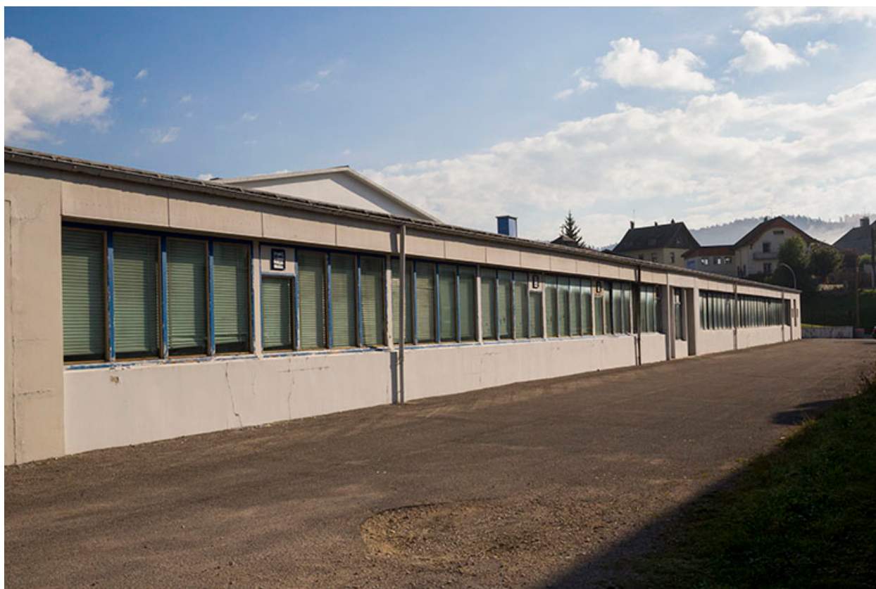
Bâtiment en rez-de-chaussée : façade méridionale.
