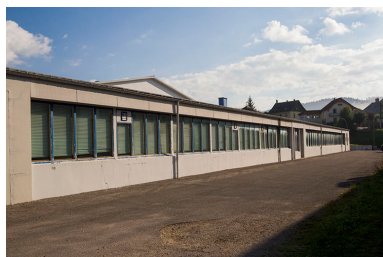
Bâtiment en rez-de-chaussée : façade méridionale. Phot. Yves Sancey IVR43_20132502113NUC2A
