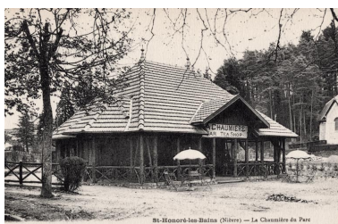
Vue ancienne. Autr. auteur inconnu IVR26_20245800639NUC4A
