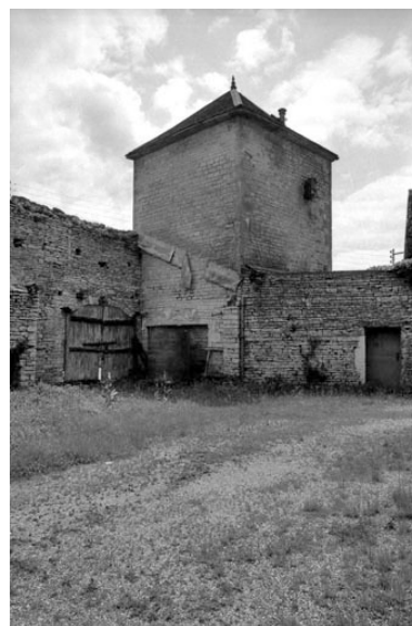
Mur d'enclos de la cour. Phot. Bernard Lardière IVR43_19817000532Z
