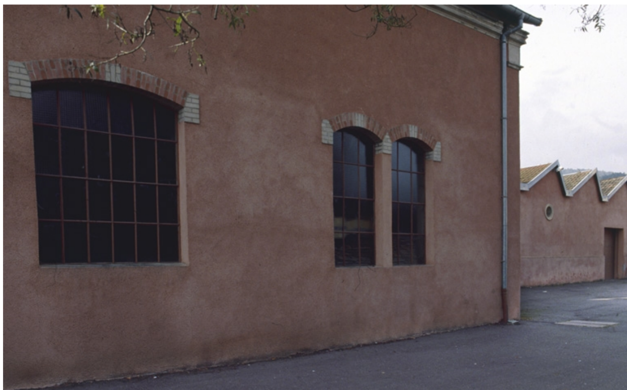
Détail de baies.
