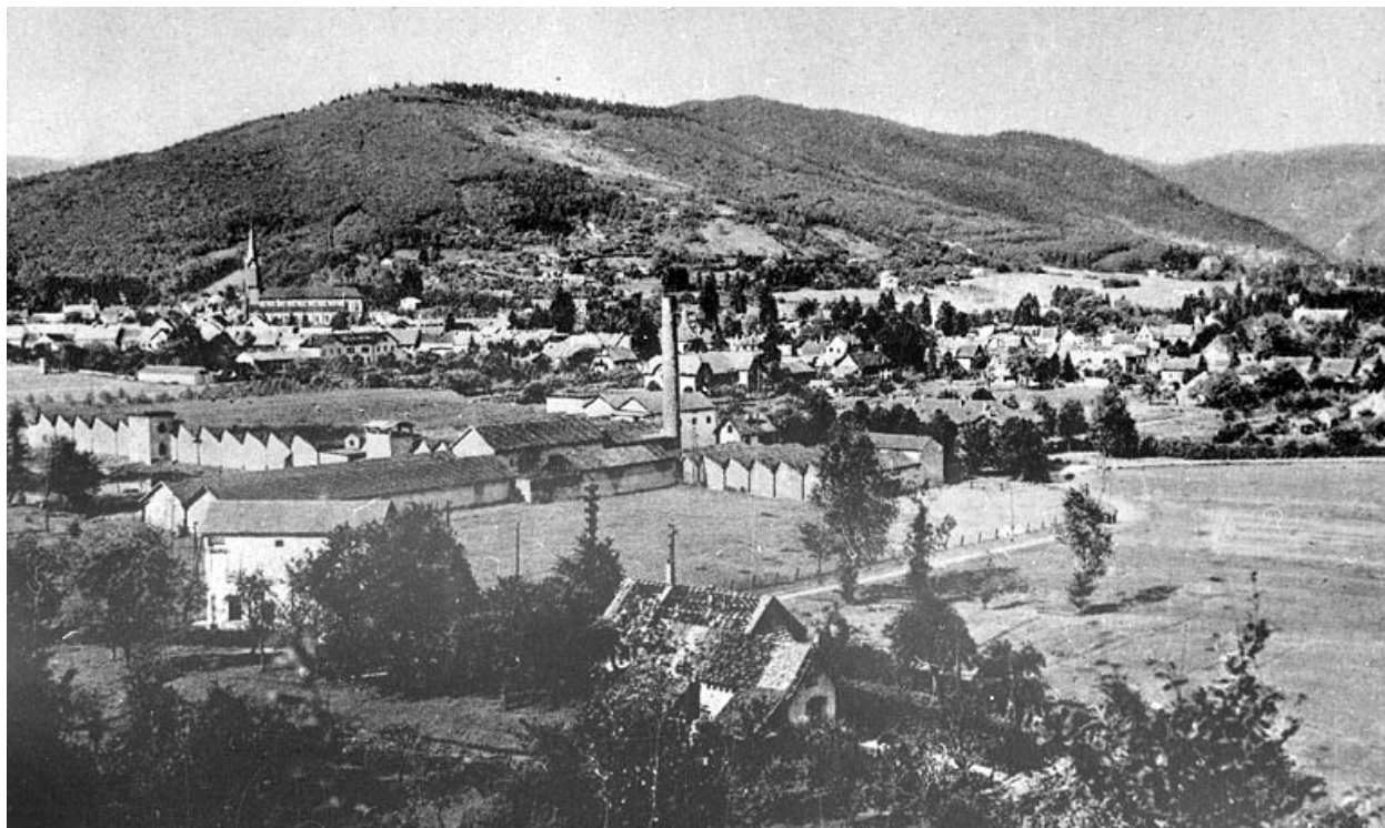
Giromagny. (Territoire de Belfort) - Vue générale.
