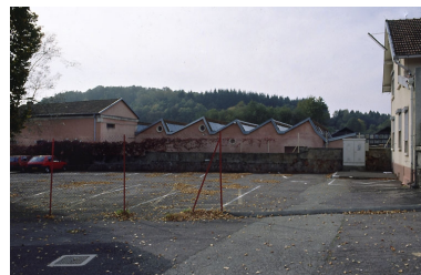
Atelier de fabrication (?) depuis l'est. Phot. Yves Sancey IVR43_19999000348ZA
