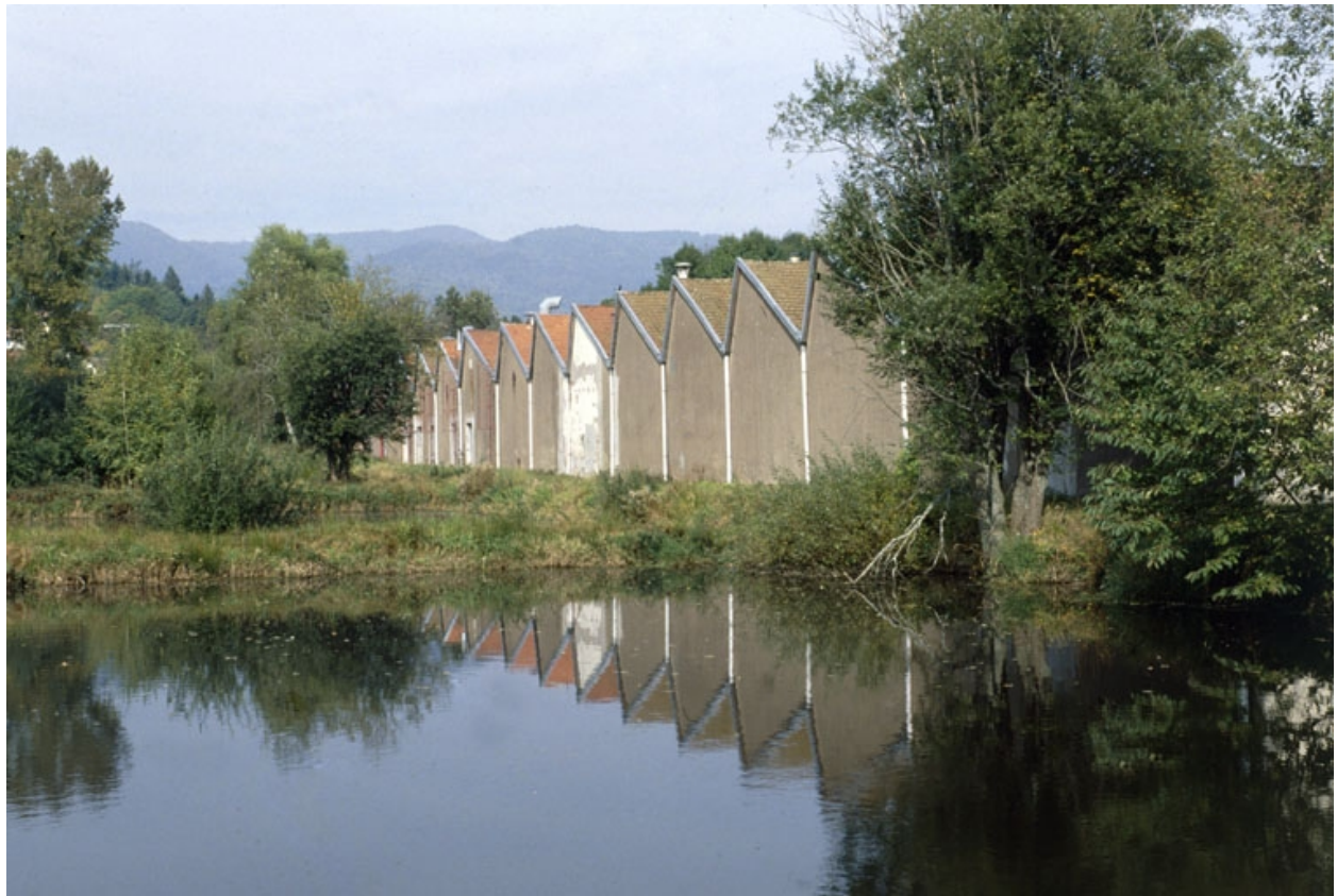
Etang et murs-pignons de l'atelier de filature.
