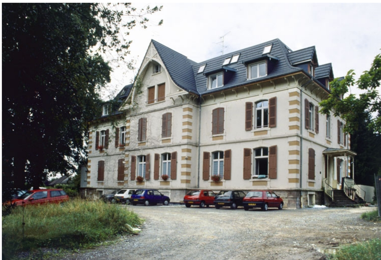
Logement patronal vu de trois quarts.
