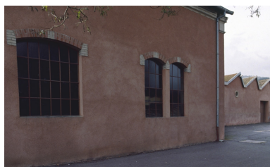
Détail de baies. Phot. Yves Sancey IVR43_19999000345ZA
