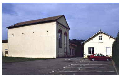
La salle des machines. Phot. Yves Sancey IVR43_19999000339ZA
