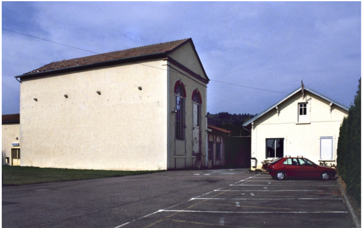
La salle des machines.
