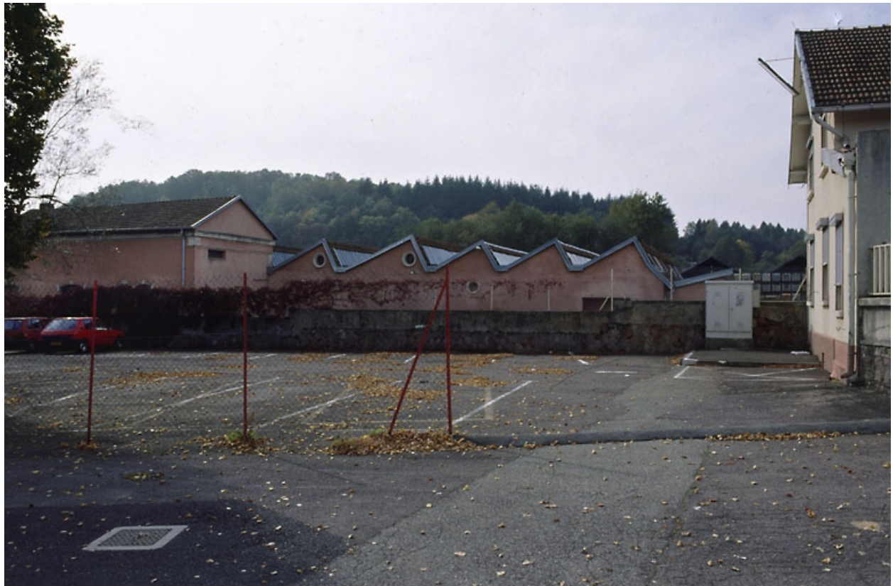
Atelier de fabrication (?) depuis l'est.
