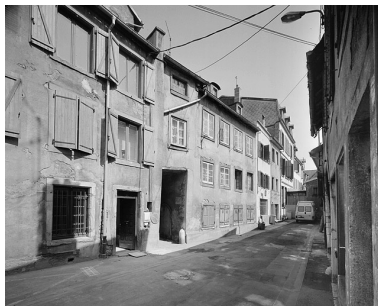
Façade sur l'impasse du Laquet. Phot. Jérôme Mongreville IVR43_19882500058V
