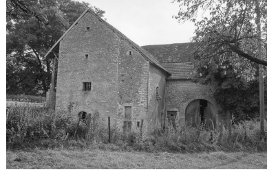
Façades sur rue. Phot. Bernard Lardière IVR43_19797000244Z
