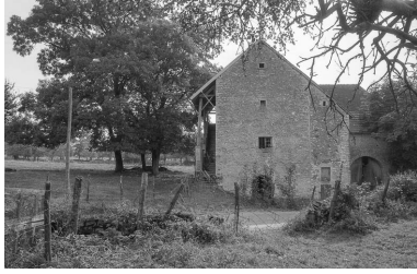
Vue d'ensemble. Phot. Bernard Lardière IVR43_19797000243Z
