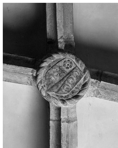
Chapelle gauche : clef de voûte. Phot. Yves Sancey IVR43_19843900218X
