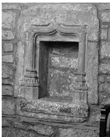
2e chapelle droite : lavabo. Phot. Yves Sancey IVR43_19843900216X
