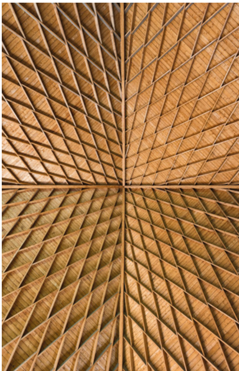
Charpente. Vue en contre-plongée.
