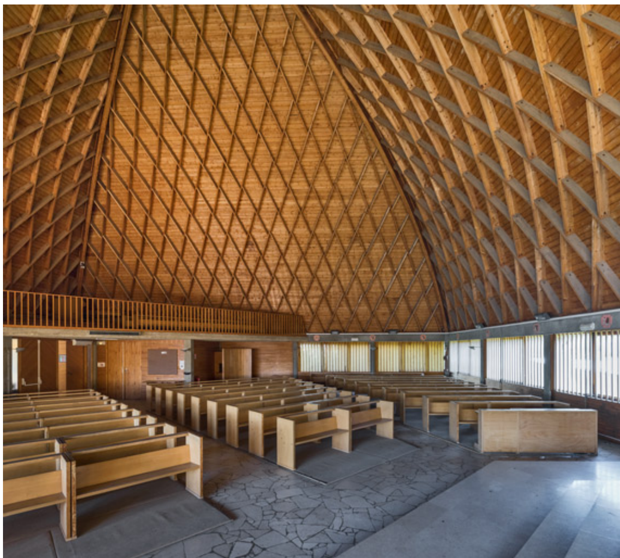
Nef. Vue en direction du nord-ouest.
