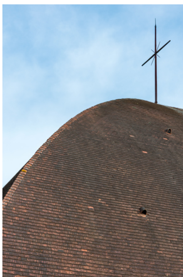
Détail du toit. Phot. Pierre-Marie Barbe-Richaud IVR26_20258900021NUC4A
