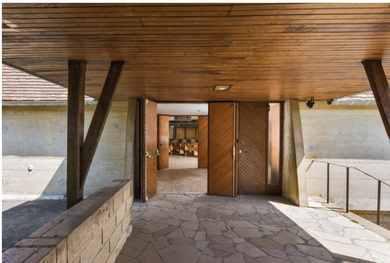
Entrée de l'église. Vue sous le porche.
