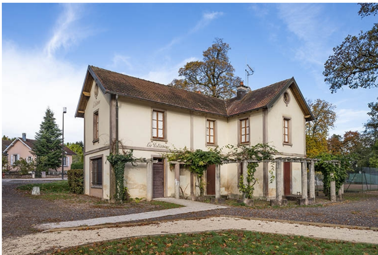
Vue depuis le sud-est.
