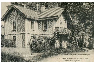
Vue ancienne. Autr. auteur inconnu IVR43_20207000746NUC4A
