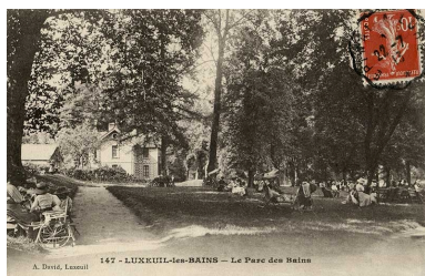
Vue ancienne. Autr. auteur inconnu IVR43_20207000749NUC4A
