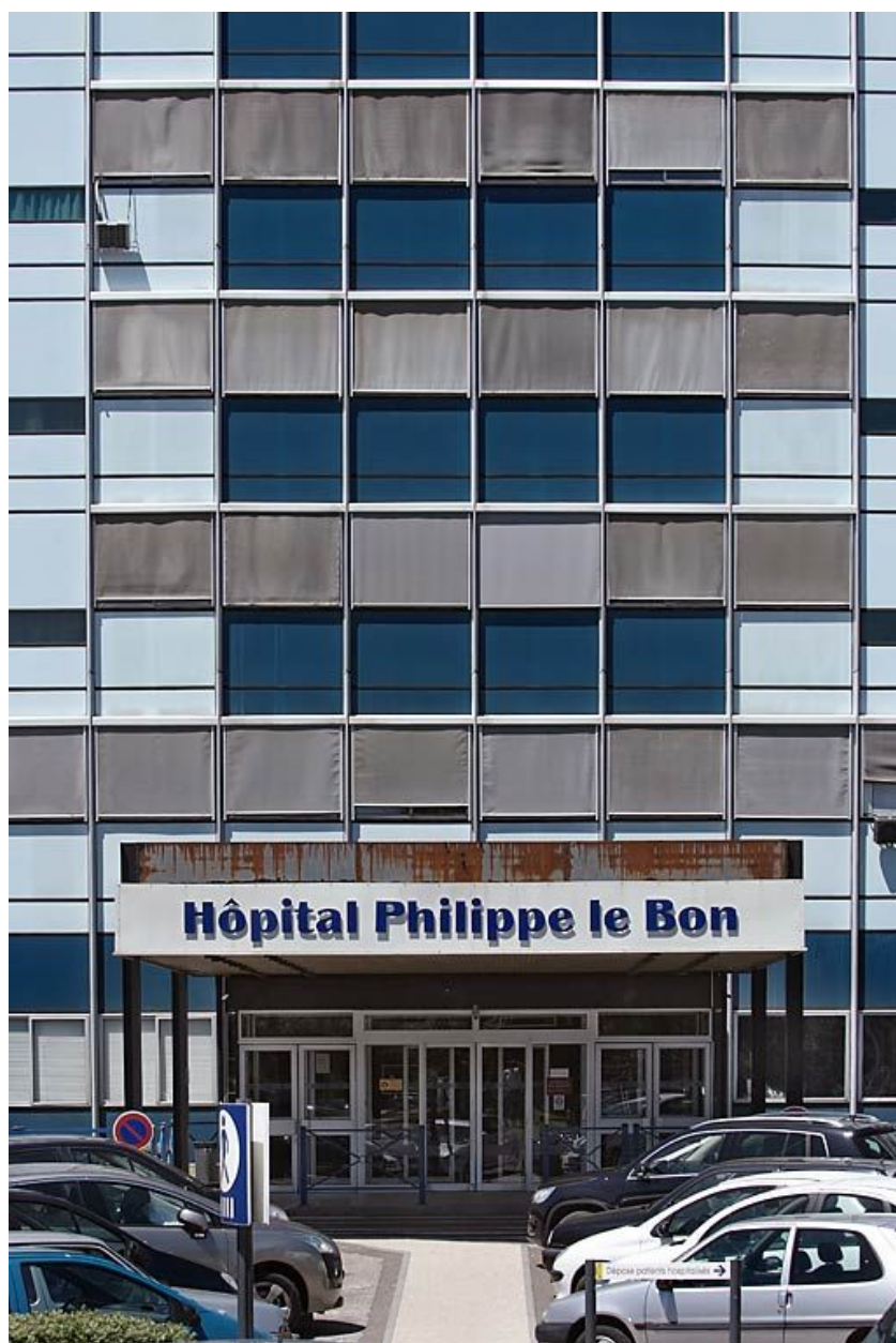
Bâtiment principal, détail de la façade.
