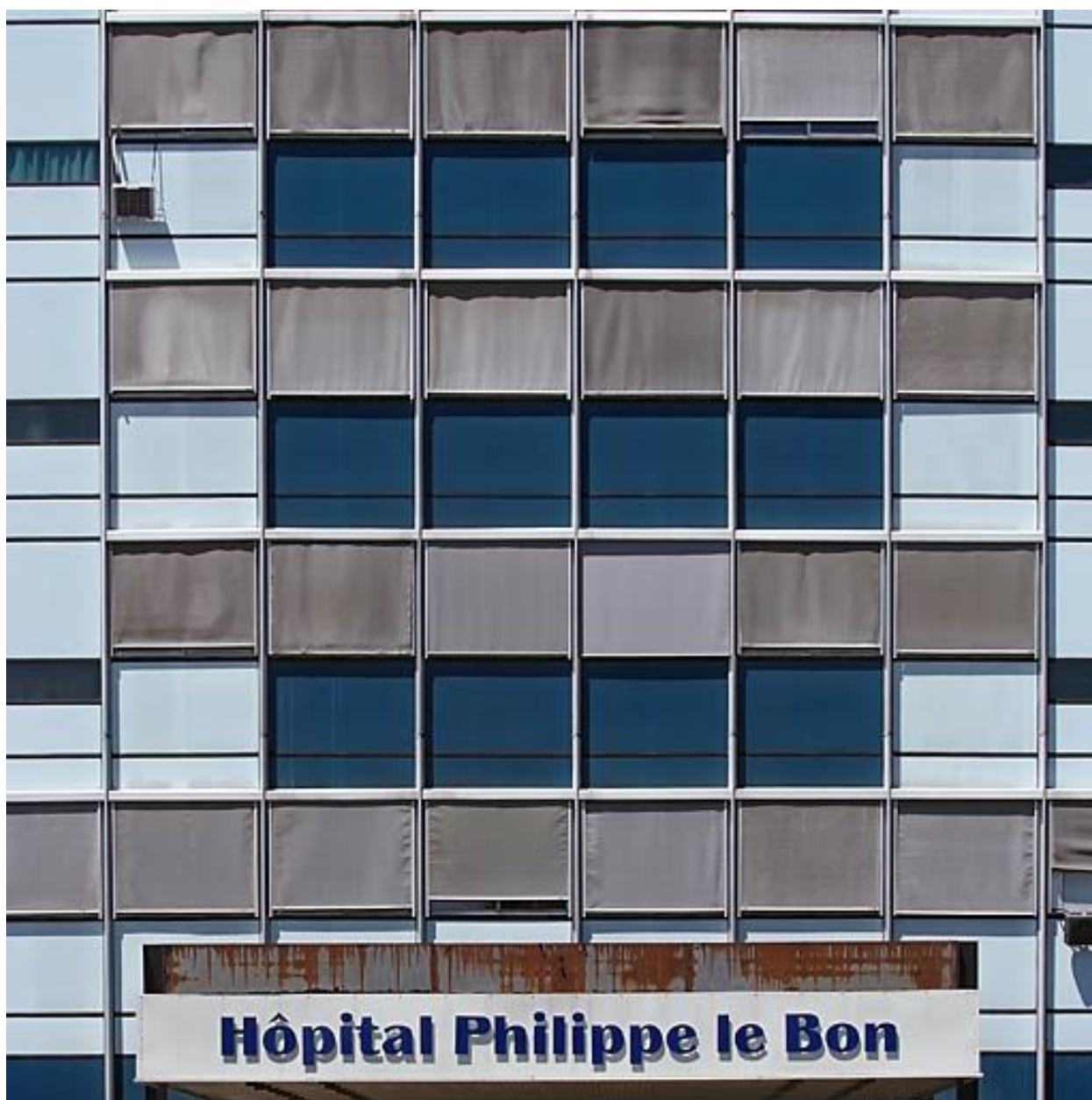
Bâtiment principal, détail de la façade.
