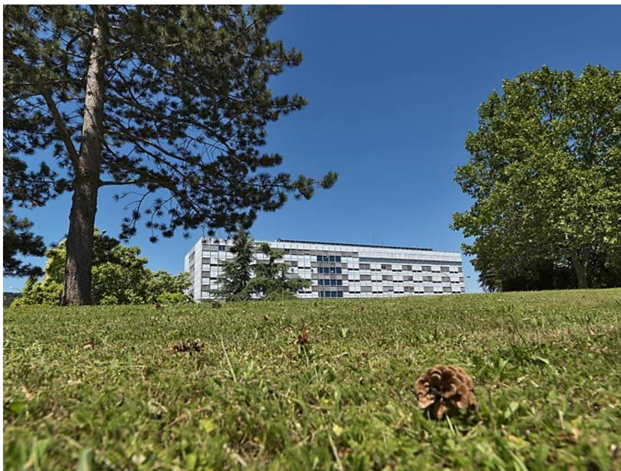
Bâtiment principal, vue d'ensemble.
