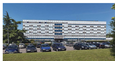
Bâtiment principal, façade. Phot. Thierry Kuntz IVR26_20102100947NUC4A
