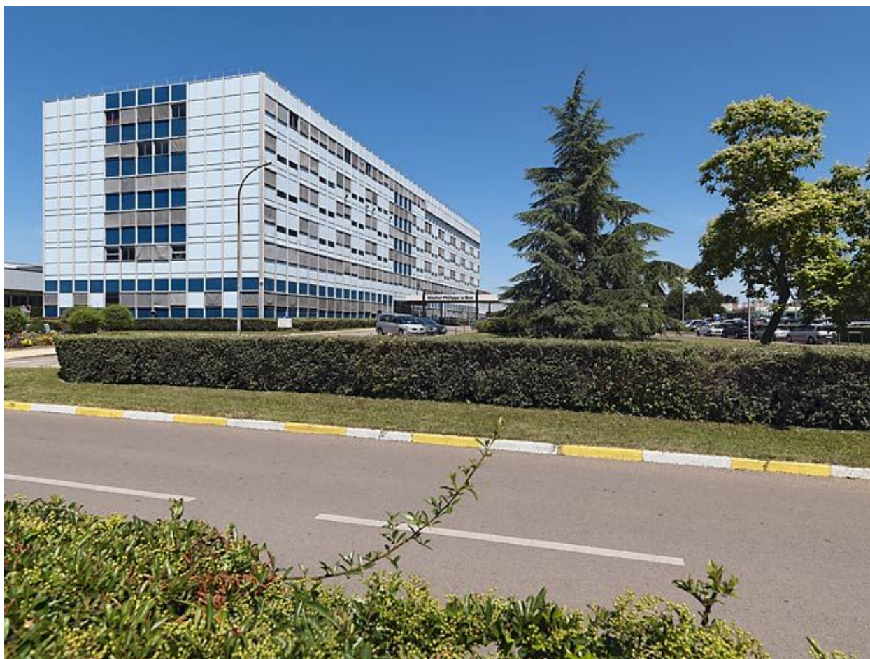
Bâtiment principal, vue d'ensemble de trois-quarts.
