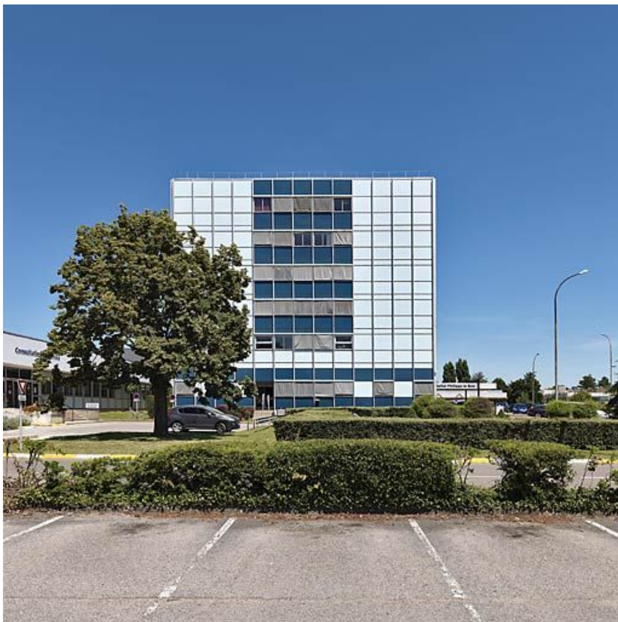
Bâtiment principal, élévation latérale.
