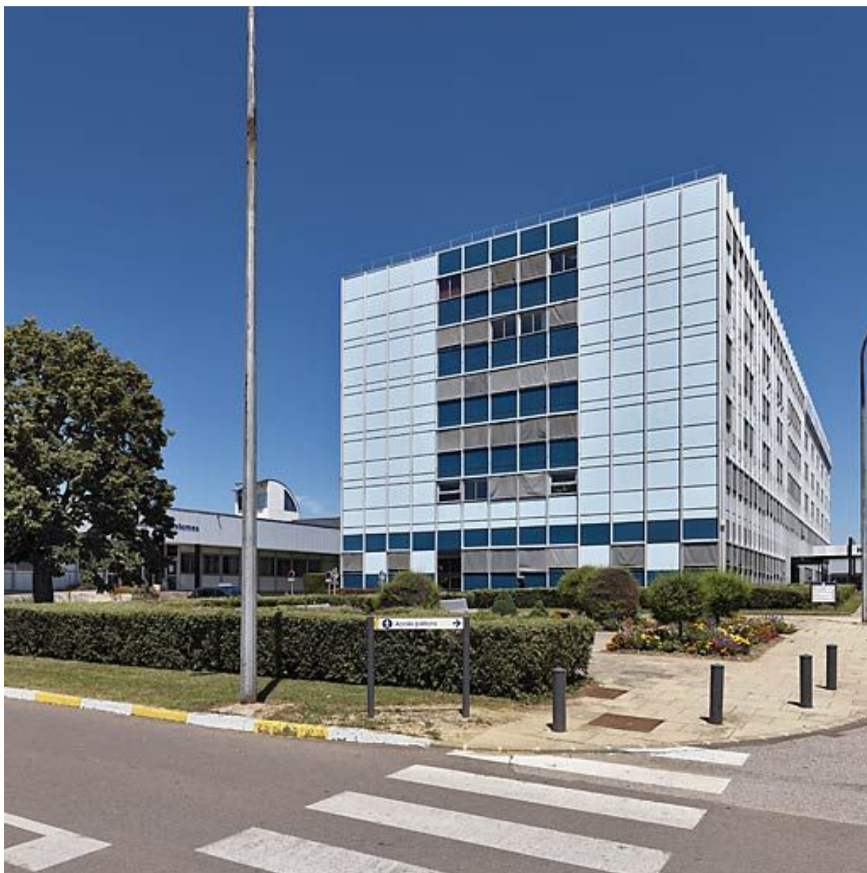
Bâtiment principal, vue d'ensemble de trois-quarts.
