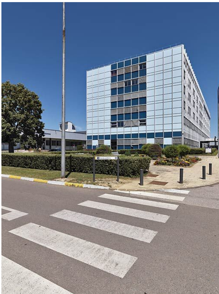
Bâtiment principal, vue d'ensemble de trois-quarts.
