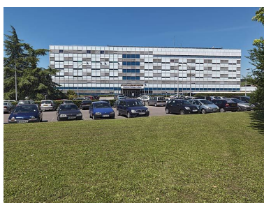
Bâtiment principal, façade. Phot. Thierry Kuntz IVR26_20102100948NUC4A
