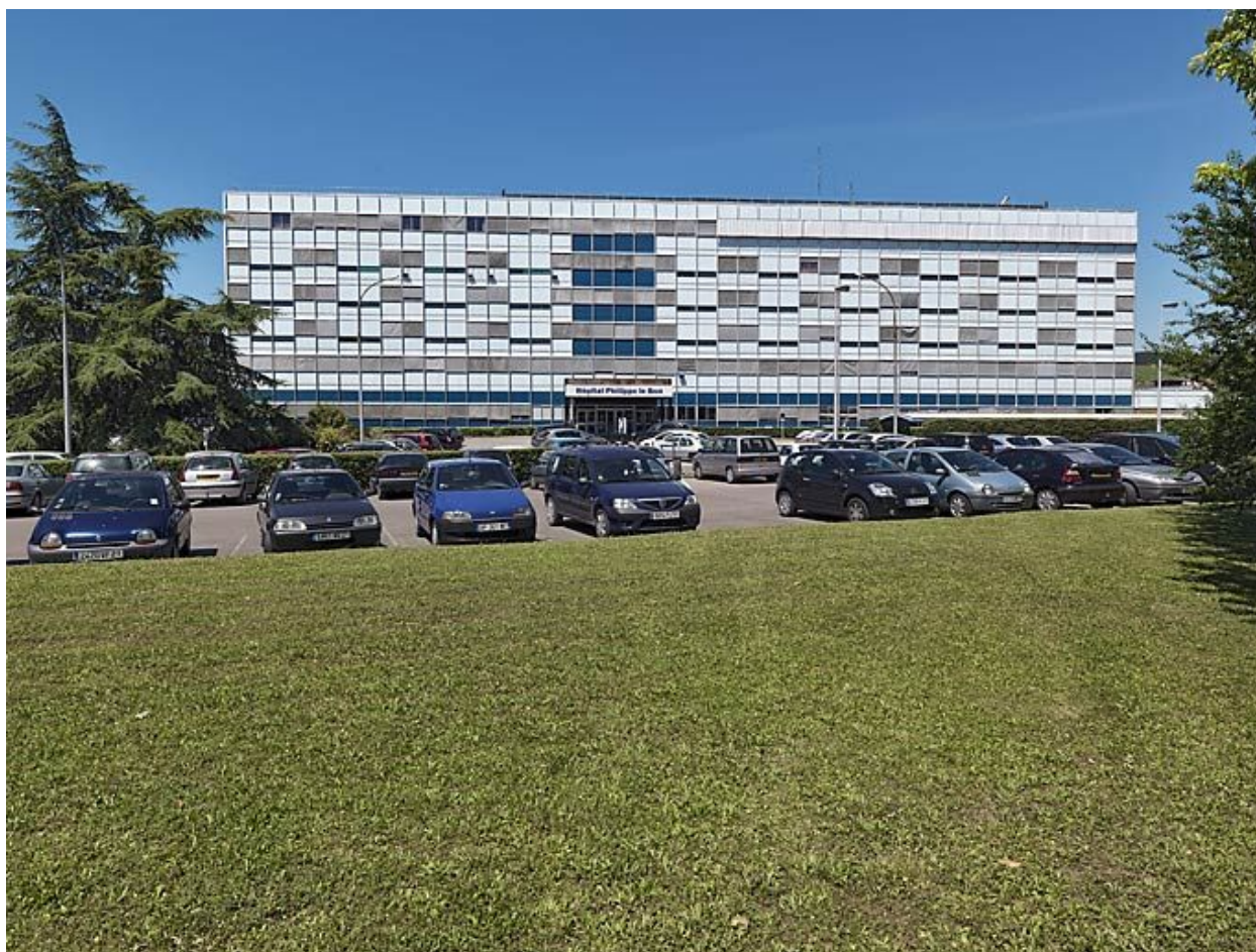
Bâtiment principal, façade.
