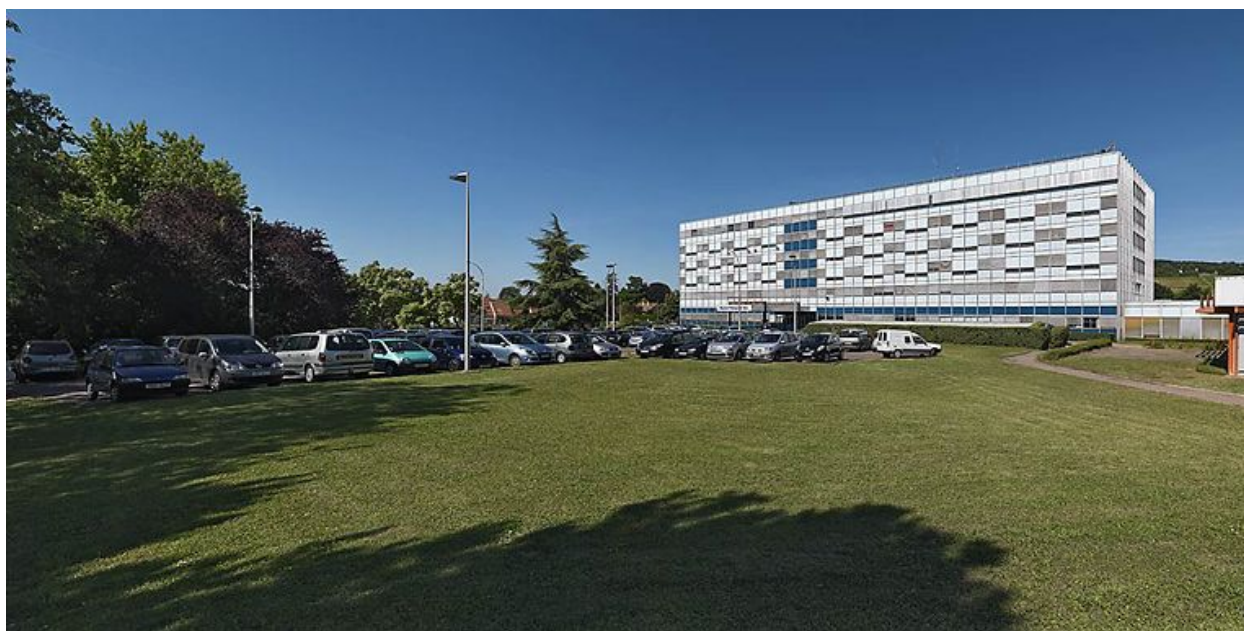
Bâtiment principal, vue d'ensemble.
