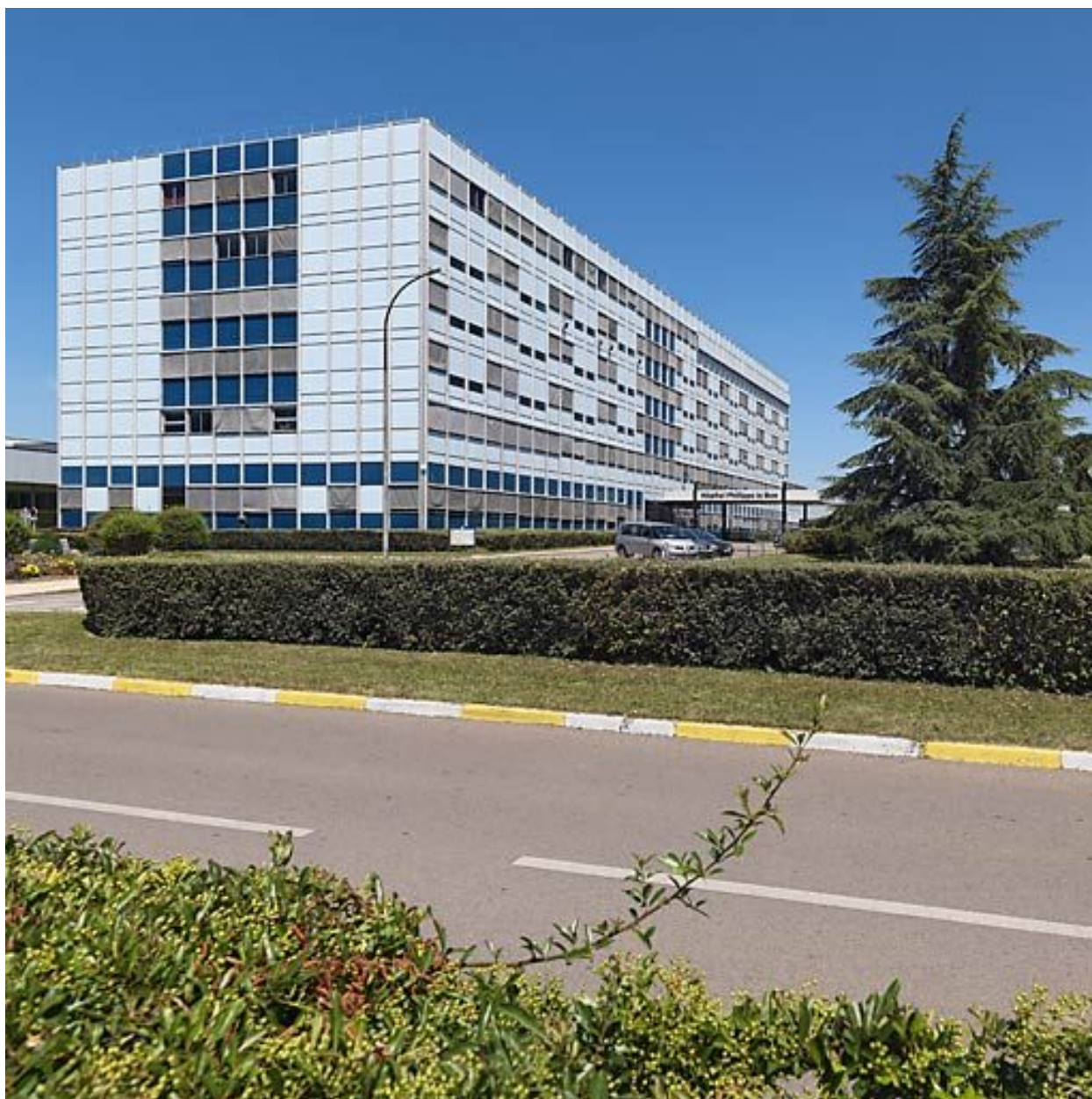
Bâtiment principal, vue d'ensemble de trois-quarts.
