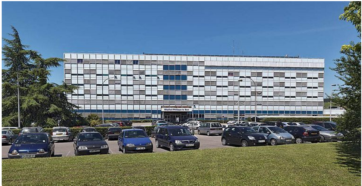
Bâtiment principal, façade.
