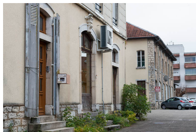
Vue depuis l'entrée. Logement et atelier. Phot. Jérôme Mongreville IVR43_20172501367NUC4A
