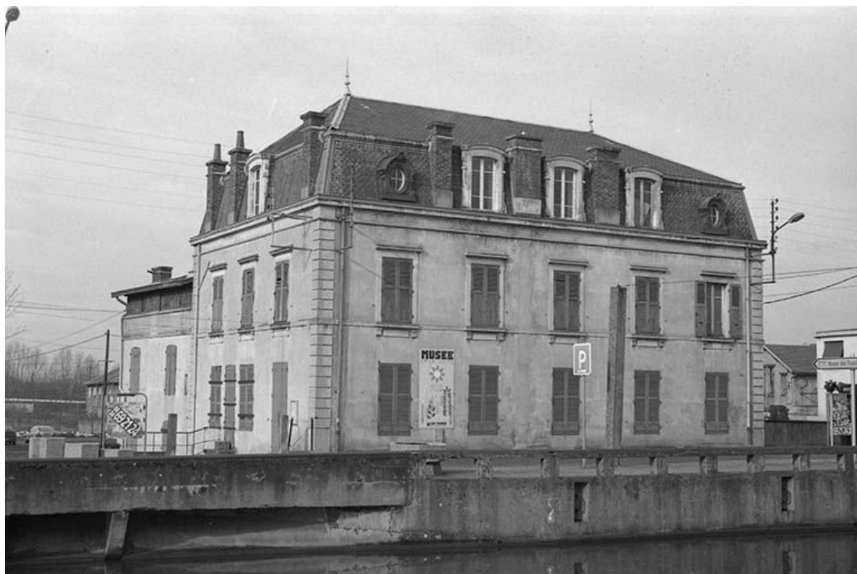
Logement d'ingénieur construit en 1847-50 : vue d'ensemble.
