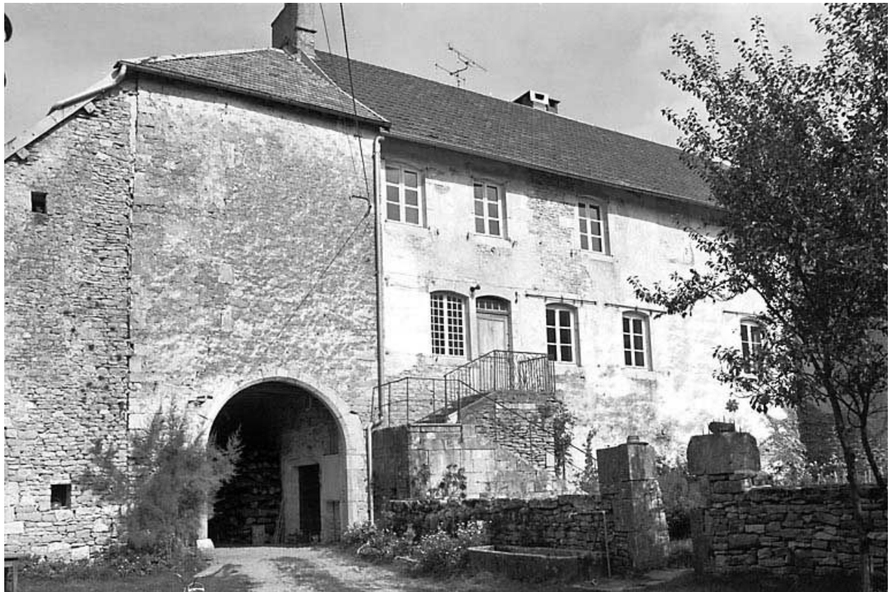
Façade antérieure et le passage voûté.
