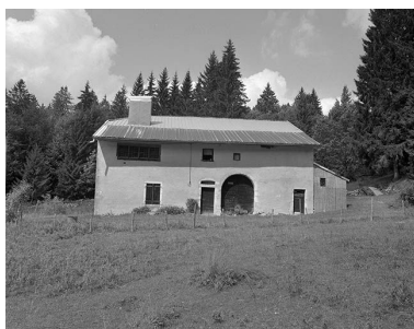
Façade sud-est. Phot. Jérôme Mongreville IVR43_20003900452X
