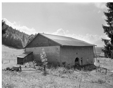
Façades nord-est et nord-ouest. Phot. Jérôme Mongreville IVR43_20003900451X
