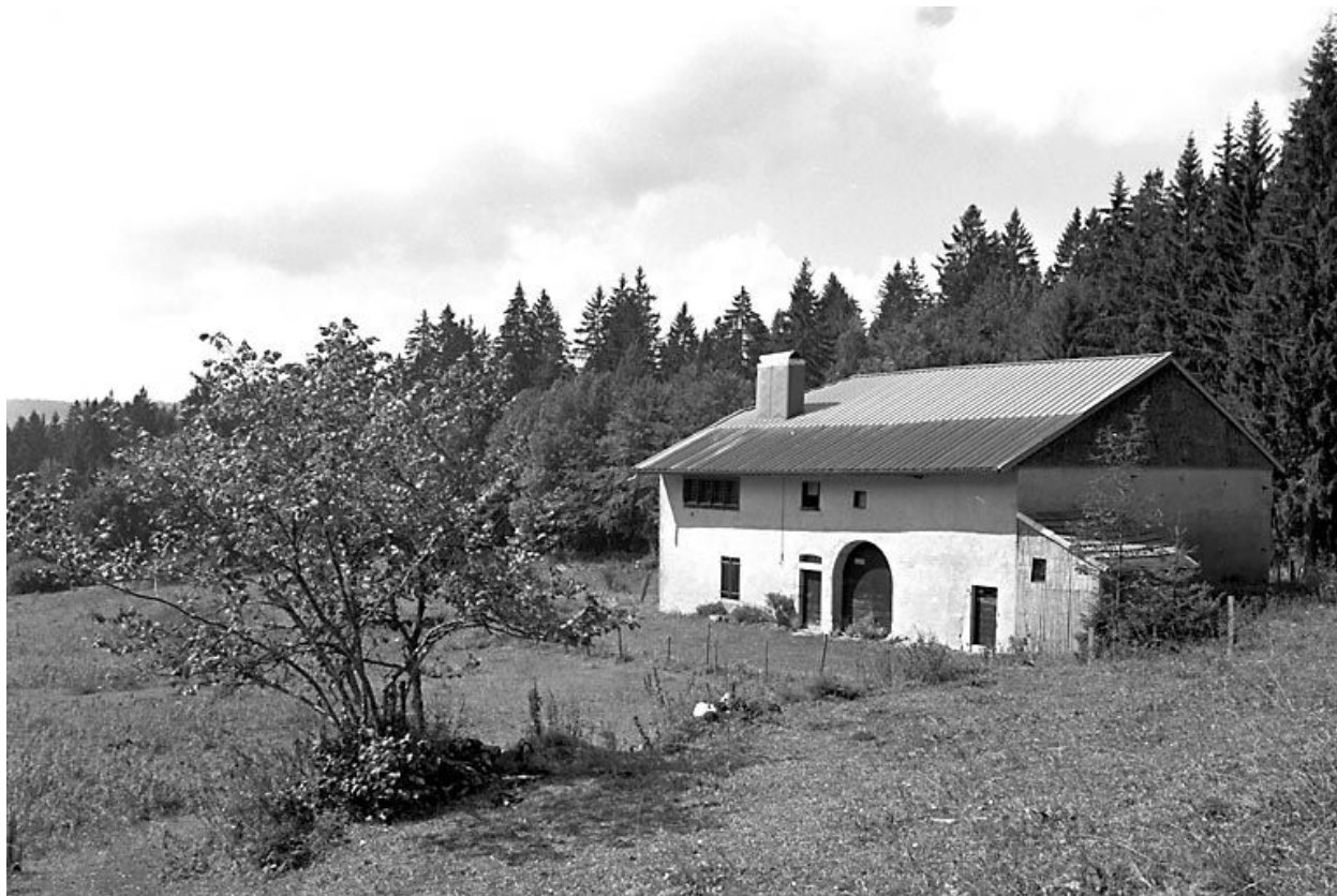
Façade sud-est, vue éloignée.
