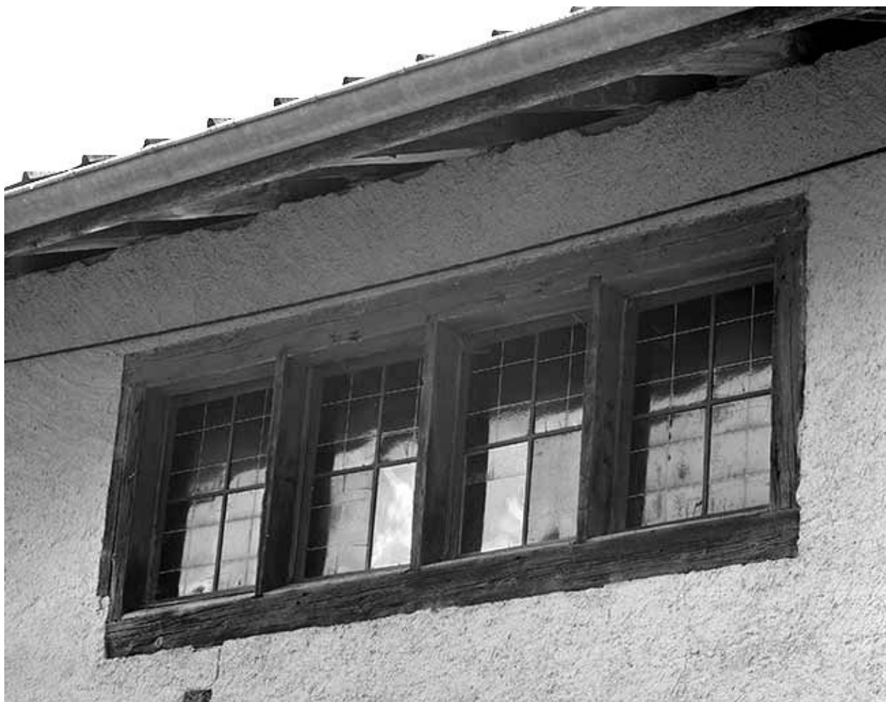
Fenêtres éclairant l'atelier ou " fenêtres de forge ".
