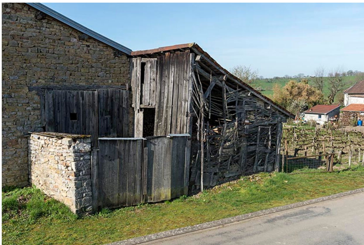
Détail d'un appentis couvert en tuiles canal, paroi en treillage, à l'angle de la Grande rue et de la rue de Jonvelle.
