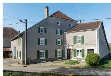
Maison ferme 23 Grande rue. Phot. Sonia Dourlot IVR43_20177000324NUC4A
