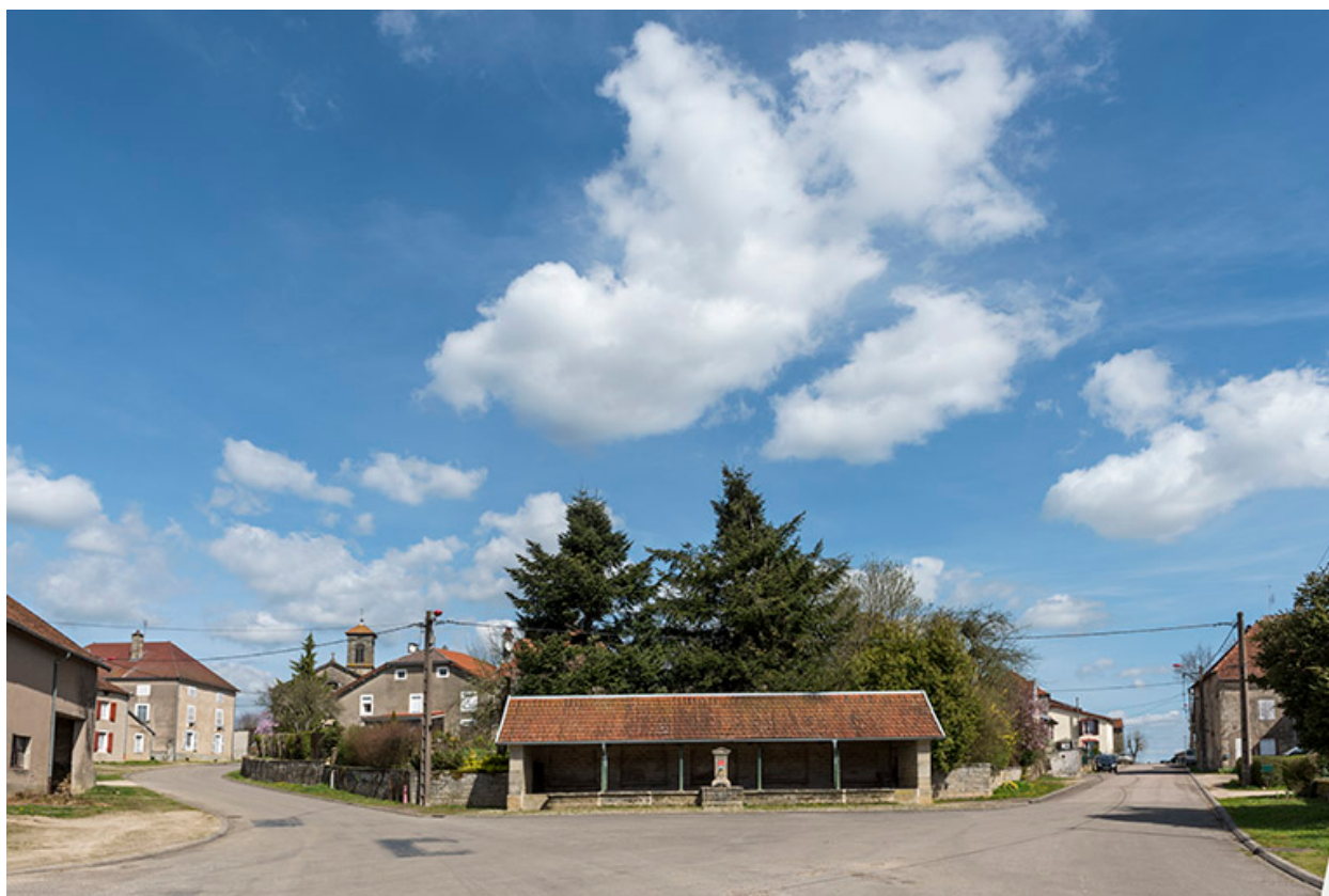
Le bas du village : vue de face du lavoir.
