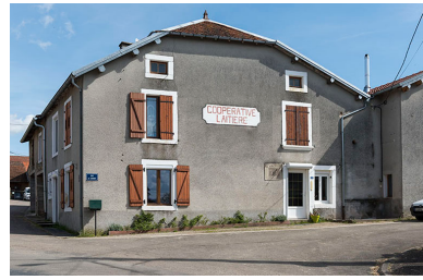
Ancienne coopérative laitière 6 rue du Cornot. Phot. Sonia Dourlot IVR43_20177000342NUC4A
