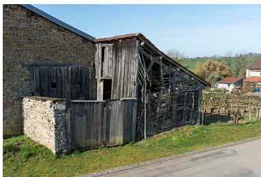
Détail d'un appentis couvert en tuiles canal, paroi en treillage, à l'angle de la Grande rue et de la rue de Jonvelle. Phot. Sonia Dourlot IVR43_20177000343NUC4A
