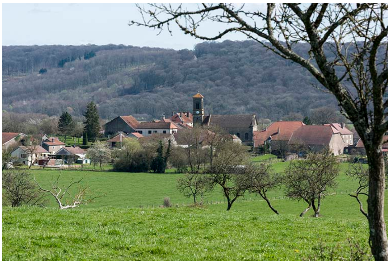
Le Grand-Magny depuis l'ouest du village.
