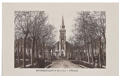
Façade principale. Repro. Pierre-Marie Barbe- Richaud, Autr. auteur inconnu IVR26_20107100699NUC2A
