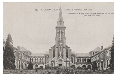
Façade principale. Repro. Pierre-Marie Barbe- Richaud, Autr. auteur inconnu IVR26_20107100709NUC2A
