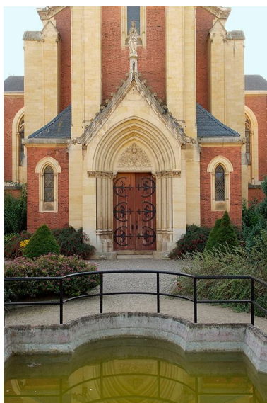
Chapelle : portail. Phot. Pierre-Marie Barbe-Richaud IVR26_20107100784NUC2A
