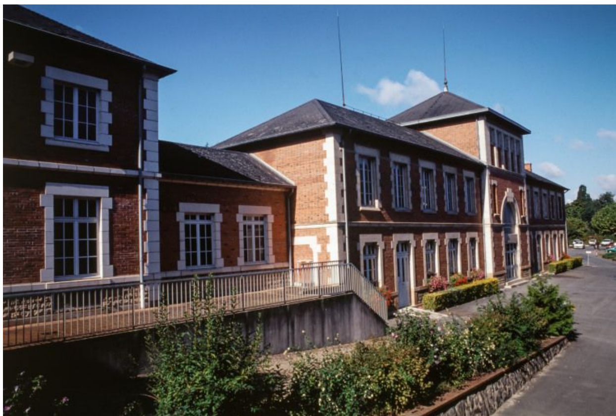
Bâtiment de service.
