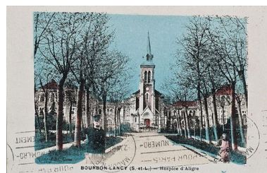
Façade principale. Repro. Pierre-Marie Barbe- Richaud, Autr. auteur inconnu IVR26_20107100700NUC2A
