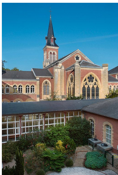
Chevet de la chapelle. Phot. Pierre-Marie Barbe-Richaud IVR26_20107100780NUC2A
