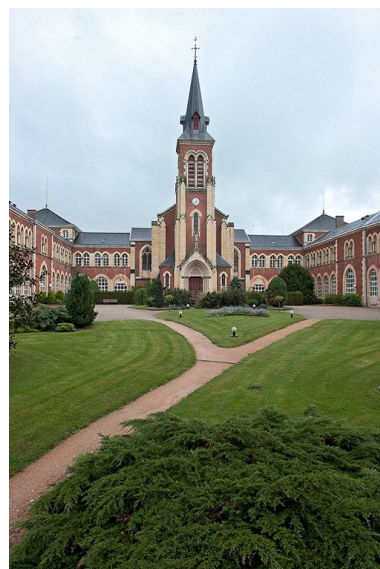
Façade de la chapelle. Phot. Pierre-Marie Barbe-Richaud IVR26_20107100775NUC2A
