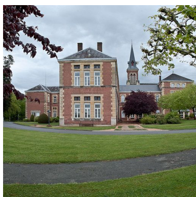
Elévation nord-ouest. Phot. Pierre-Marie Barbe-Richaud IVR26_20107100778NUC2AQ
