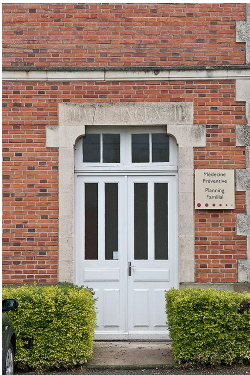
Bâtiment de services : porte latérale.
