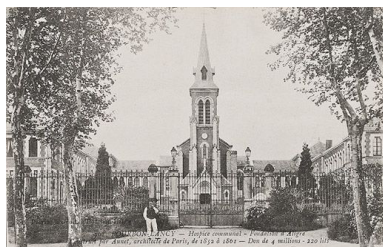
Façade principale. Repro. Pierre-Marie Barbe- Richaud, Autr. auteur inconnu IVR26_20107100704NUC2A
