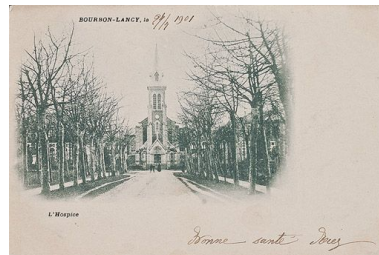
Façade principale. Repro. Pierre-Marie Barbe- Richaud, Autr. auteur inconnu IVR26_20107100698NUC2A
