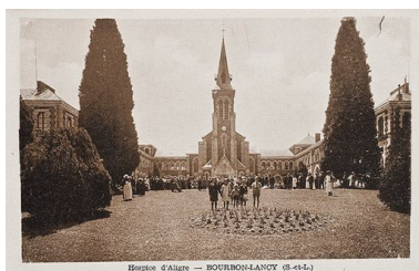
Façade principale. Repro. Pierre-Marie Barbe- Richaud, Autr. auteur inconnu IVR26_20107100707NUC2A
