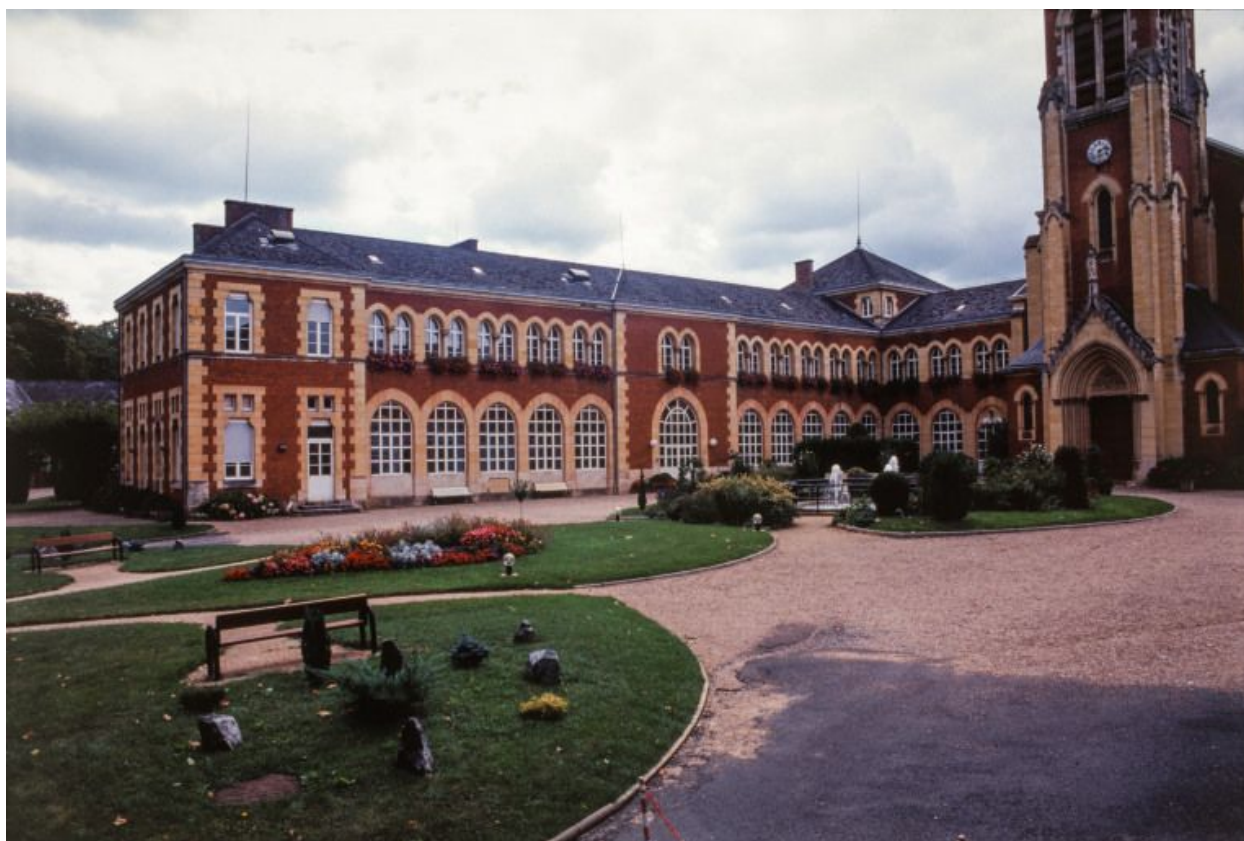
Aile gauche, façade antérieure.
