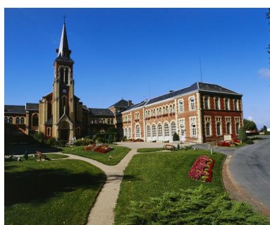
Chapelle et aile droite. Phot. Jean-Luc Duthu IVR26_20017100695XA
