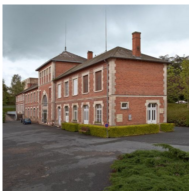
Bâtiment de service. Phot. Pierre-Marie Barbe-Richaud IVR26_20107100792NUC2AQ
