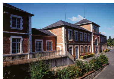
Bâtiment de service. Phot. Jean-Luc Duthu IVR26_20017100720ZA
