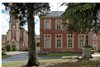
Pavillon de l'aile droite. Phot. Pierre-Marie Barbe-Richaud IVR26_20107100776NUC2A
