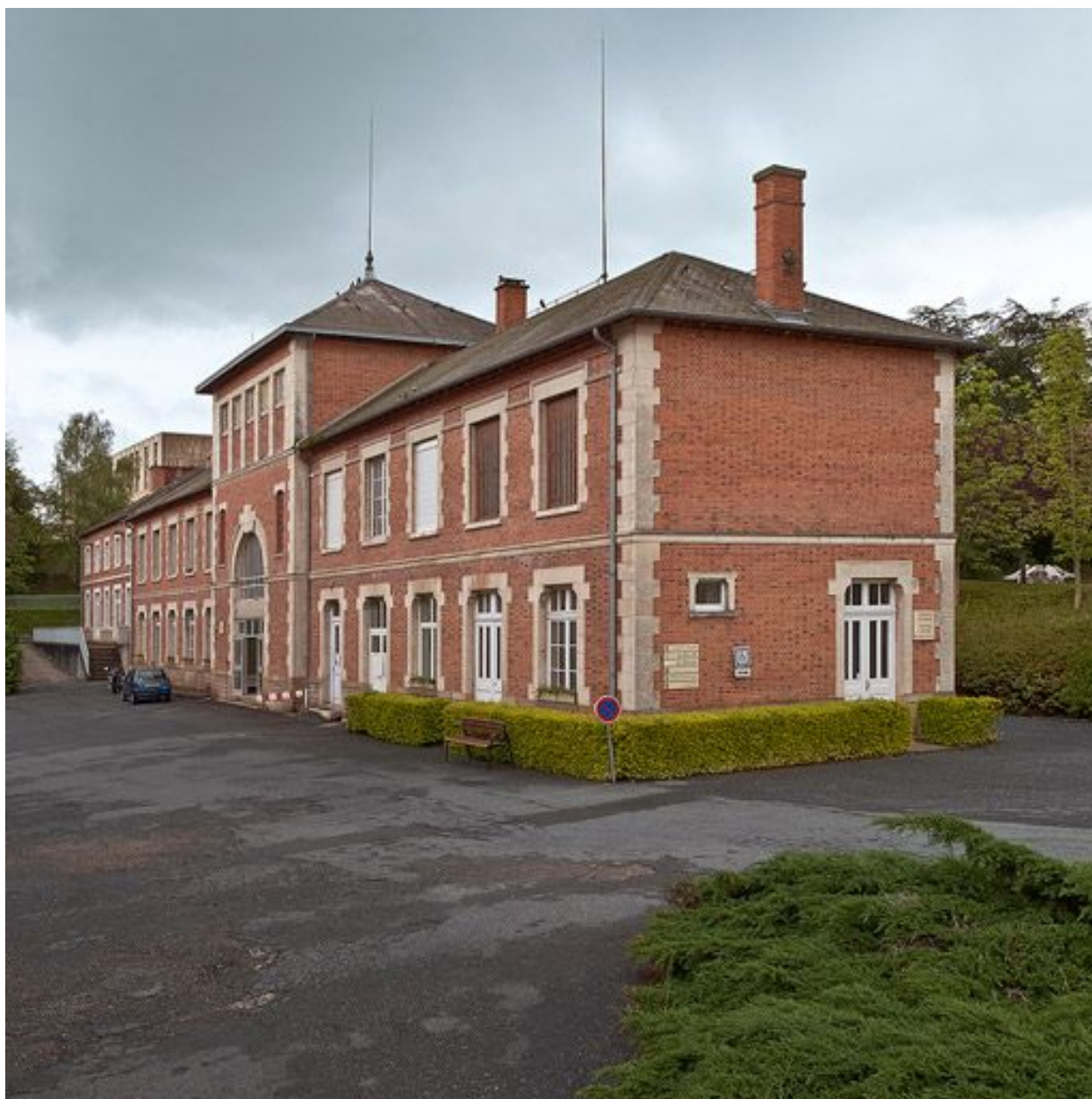
Bâtiment de service.
