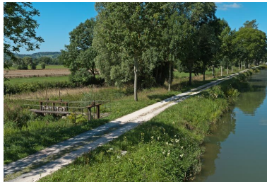
Vue des vannes de prise d'eau. Phot. Pierre-Marie Barbe-Richaud IVR26_20112103687NUC4AQ
