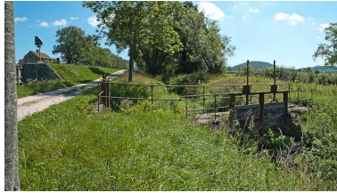
Vue des vannes de prise d'eau. Phot. Pierre-Marie Barbe-Richaud IVR26_20112103688NUC4AQ
