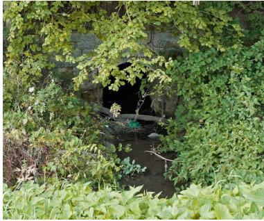
Vue de l'aqueduc. Phot. Pierre-Marie Barbe-Richaud IVR26_20112103697NUC2AQ
