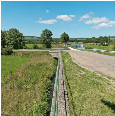
Vue du pont sur rigole. Phot. Pierre-Marie Barbe-Richaud IVR26_20112103695NUC2AQ
