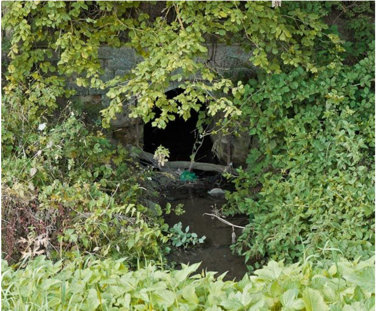
Vue de l'aqueduc.
