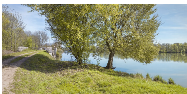
Vue d'ensemble, d'aval. Phot. Thierry Kuntz IVR26_20162101430NUC4A
