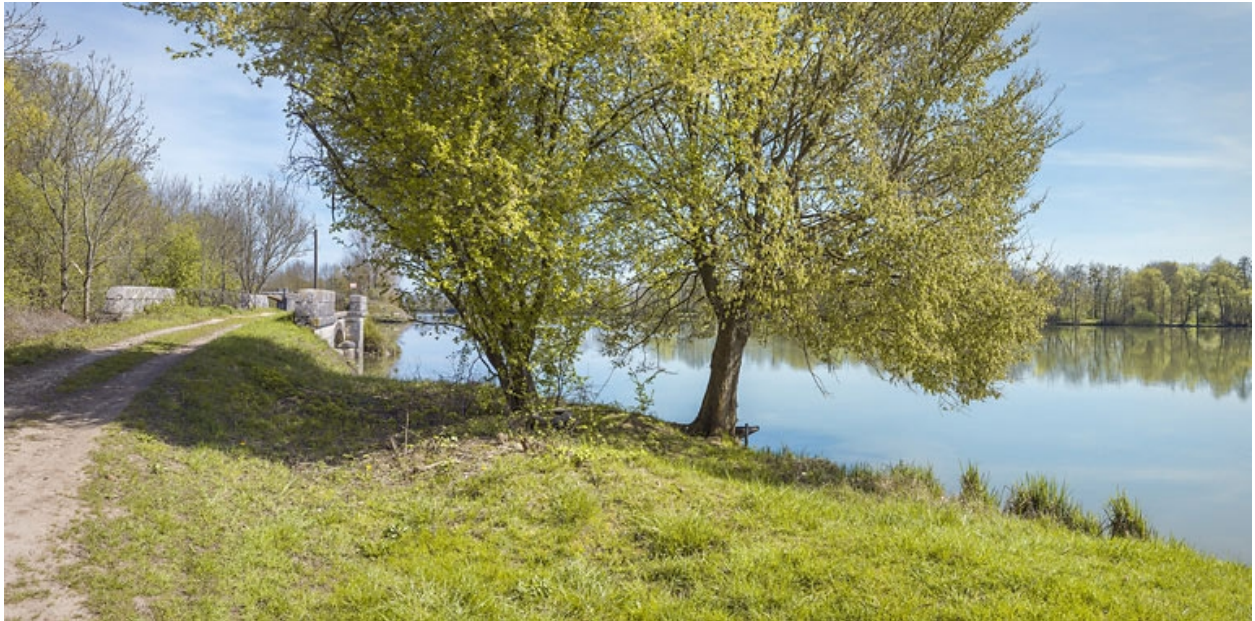
Vue d'ensemble, d'aval.
