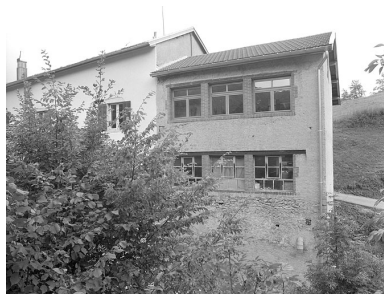
ferme, moulin à farine, scierie, atelier de tournerie dit moulin de la Rochette ou moulin d'Aval, actuellement maison, atelier de poterie Phot. Jérôme Mongreville IVR43_19963901422X
