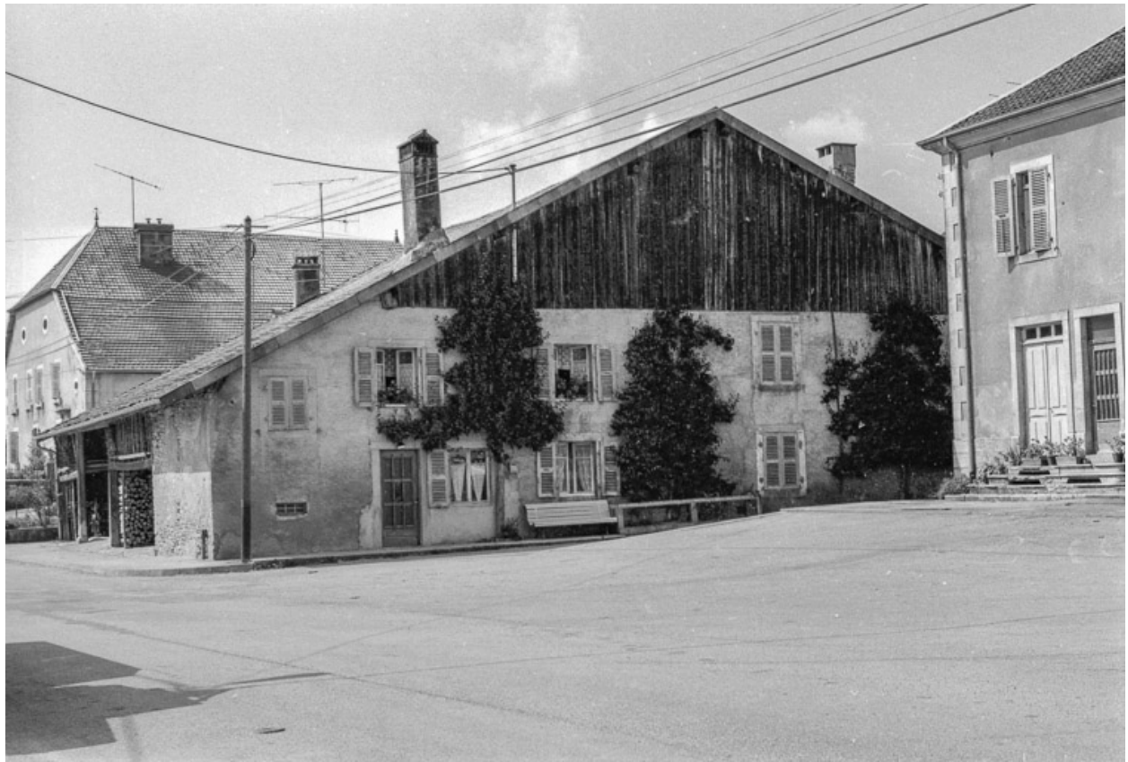
Façades antérieure et latérale droite.
