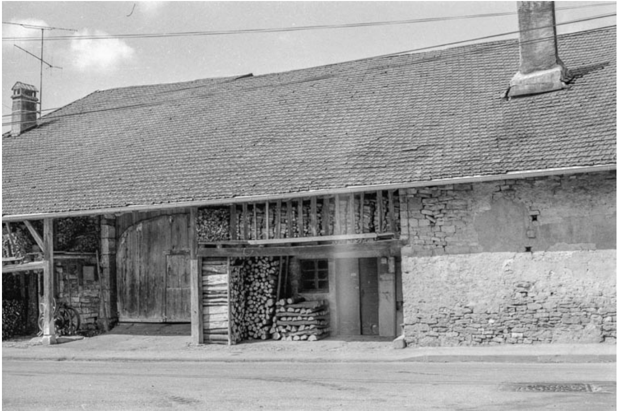
Détail de la façade sur rue.
