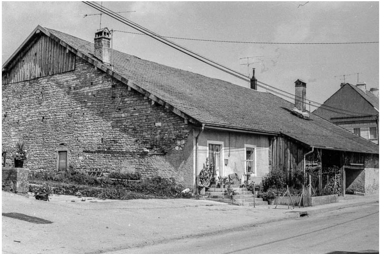
Façade sur rue et façade postérieure.
