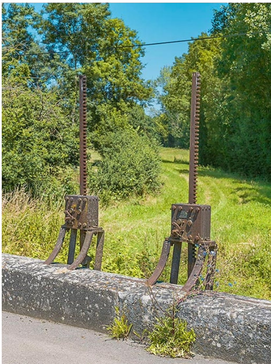
Détail des deux vannes du ponceau.
