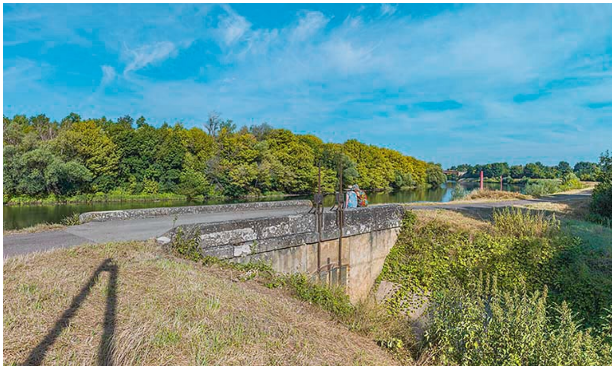
Vue d'ensemble du ponceau.
