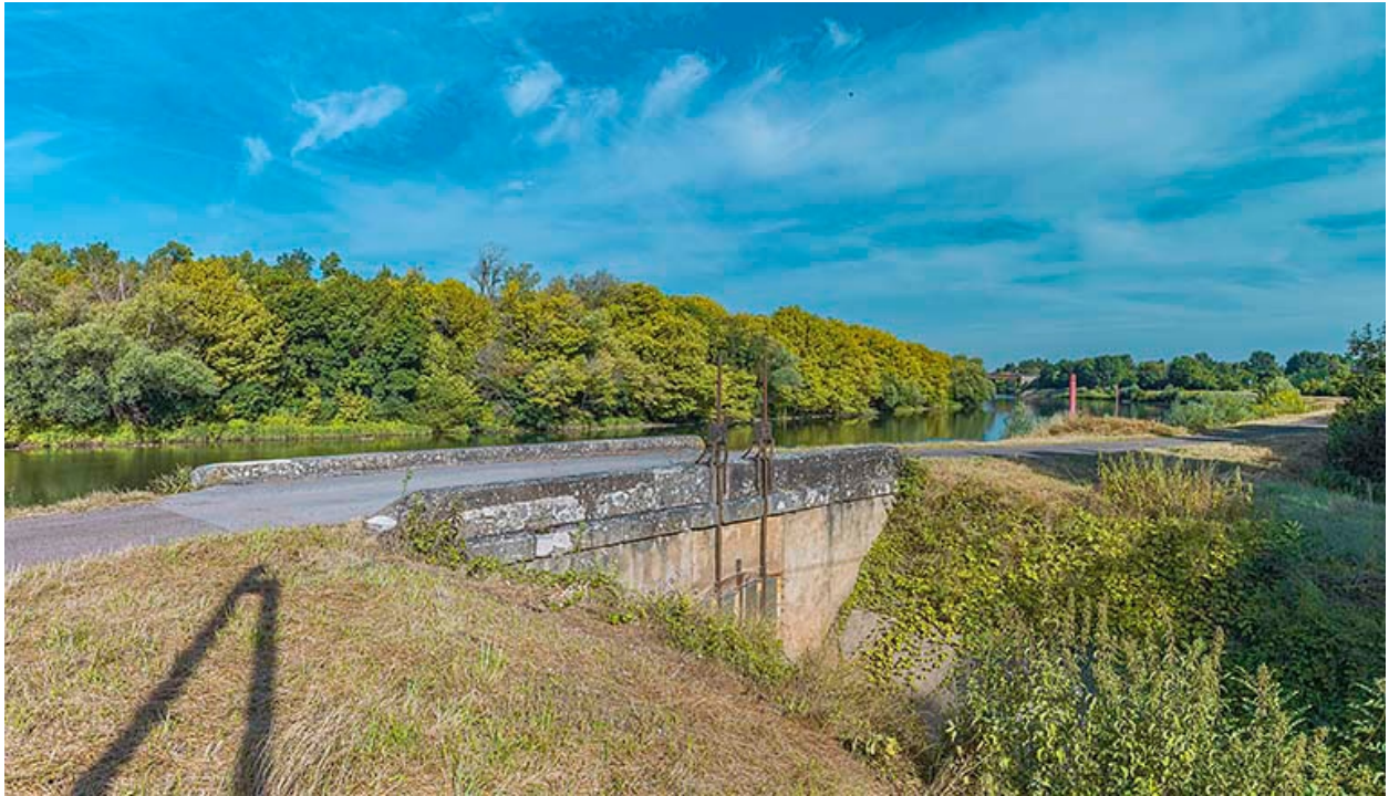
Vue d'ensemble du ponceau.
