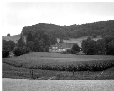
Demeure située route de Villeneuve au lieudit Pré de la Canne.
