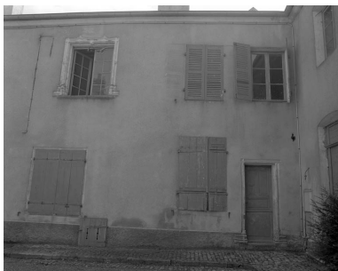
Façade antérieure du logement gauche sur cour. Phot. Yves Sancey IVR43_19897000165X
