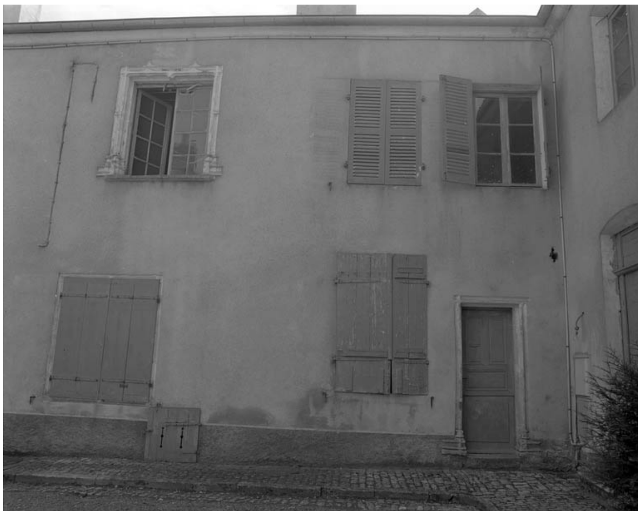
Façade antérieure du logement gauche sur cour.
