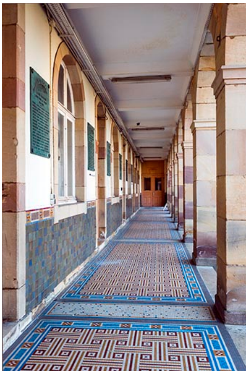
Sous les arcades ouest de la façade antérieure du corps central du grand lycée.
