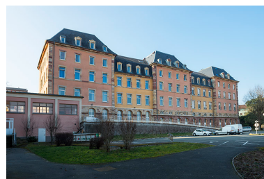
Façade orientale de l'aile est du grand lycée. Phot. Mary Ruffinoni IVR43_20149000028NUC4A
