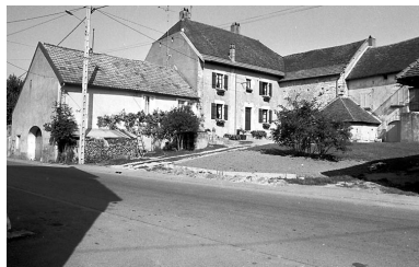
Vue d'ensemble. Phot. Bernard Lardière IVR43_19797000110Z
