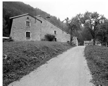
Ferme située au lieu- dit À la Boissière. Phot. Jérôme Mongreville IVR43_19943901126X
