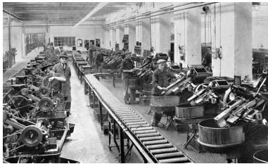
Batterie de machines automatiques à fileter et à fendre les têtes. Phot. Yves Sancey IVR43_20009000880X
