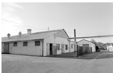
Ateliers de fabrication depuis l'est. Phot. Yves Sancey IVR43_20009000955X
