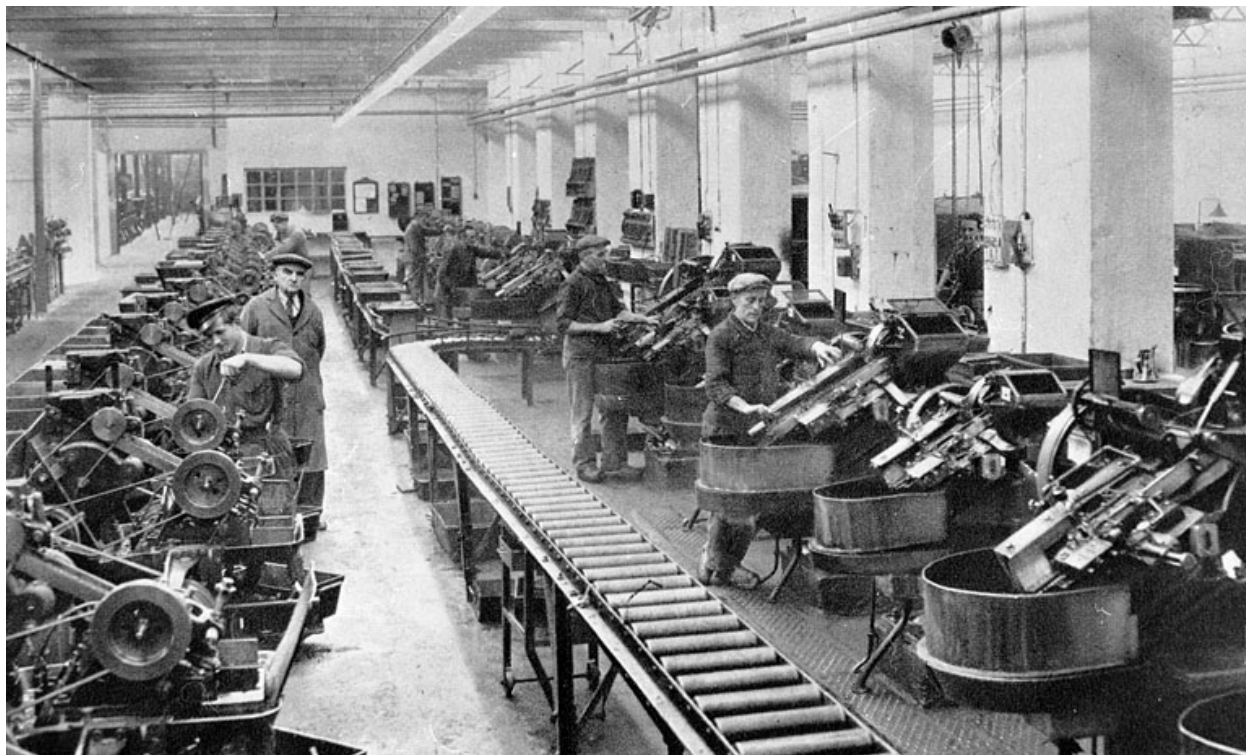
Batterie de machines automatiques à fileter et à fendre les têtes.
