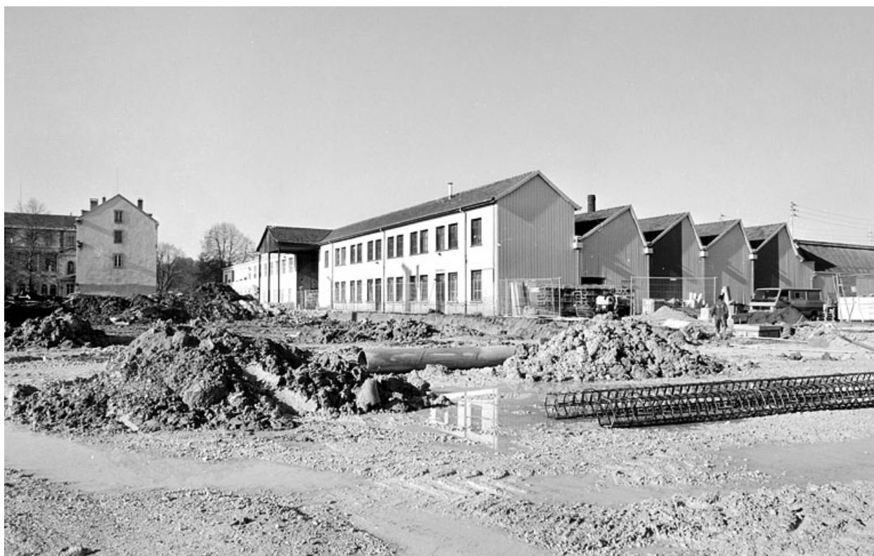
Façades postérieures des ateliers de fabrication.
