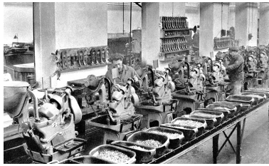
Machines automatiques à tarauder les écrous. Phot. Yves Sancey IVR43_20009000882X
