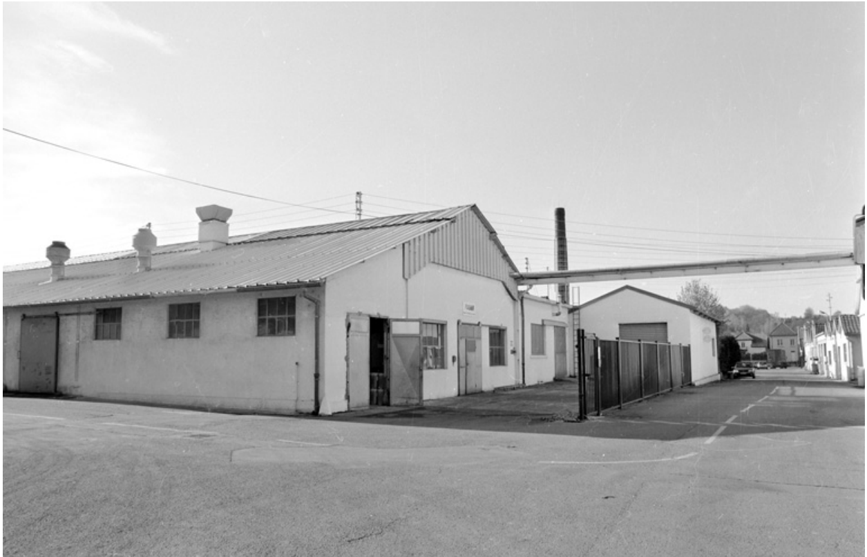
Ateliers de fabrication depuis l'est.
