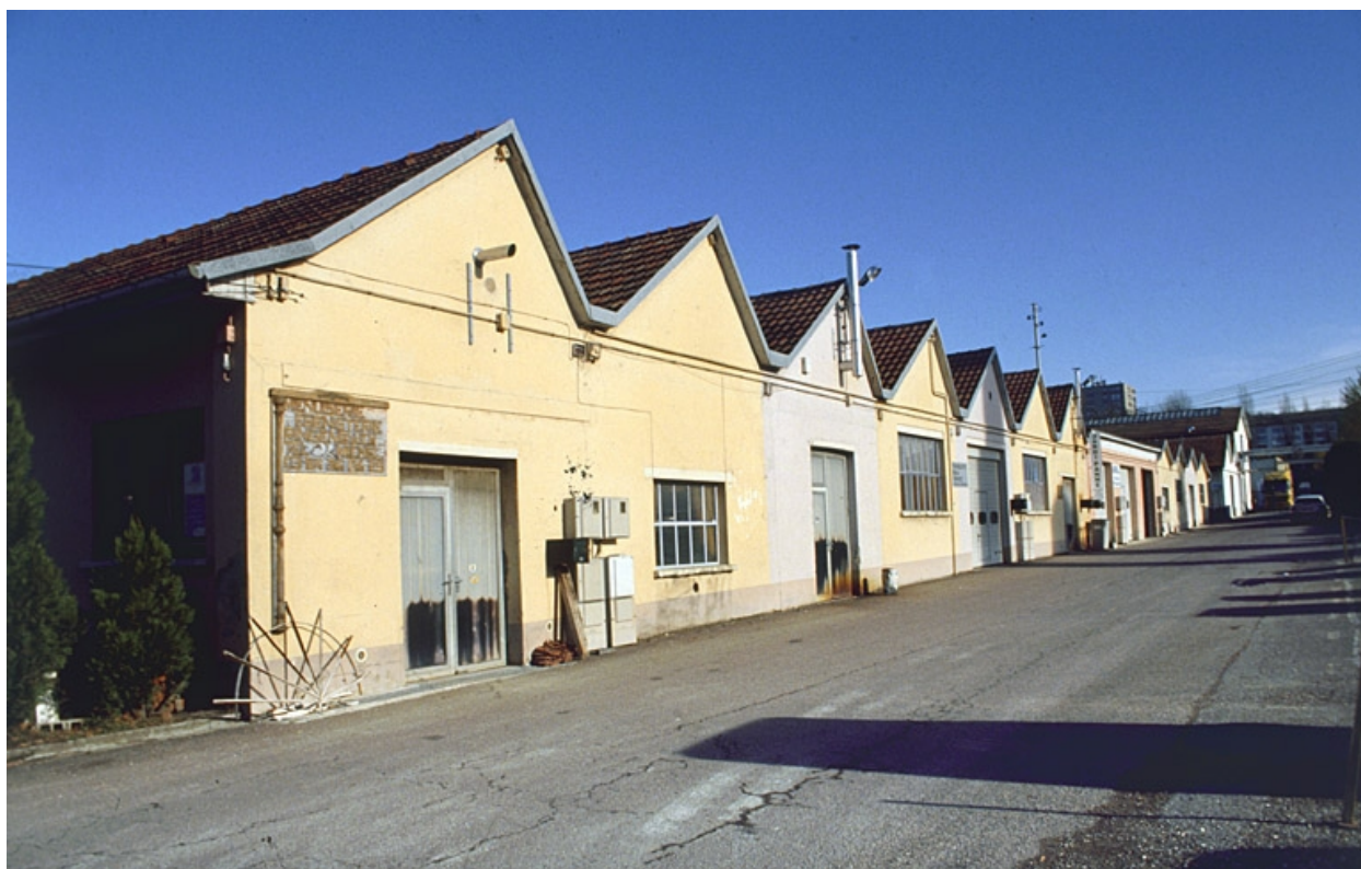
Murs-pignons d'ateliers (forge, menuiserie) et de remises.
