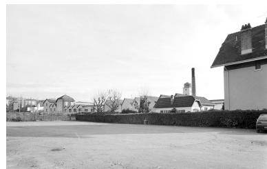
Murs-pignons nord de l'usine. Phot. Yves Sancey IVR43_20009000940X
