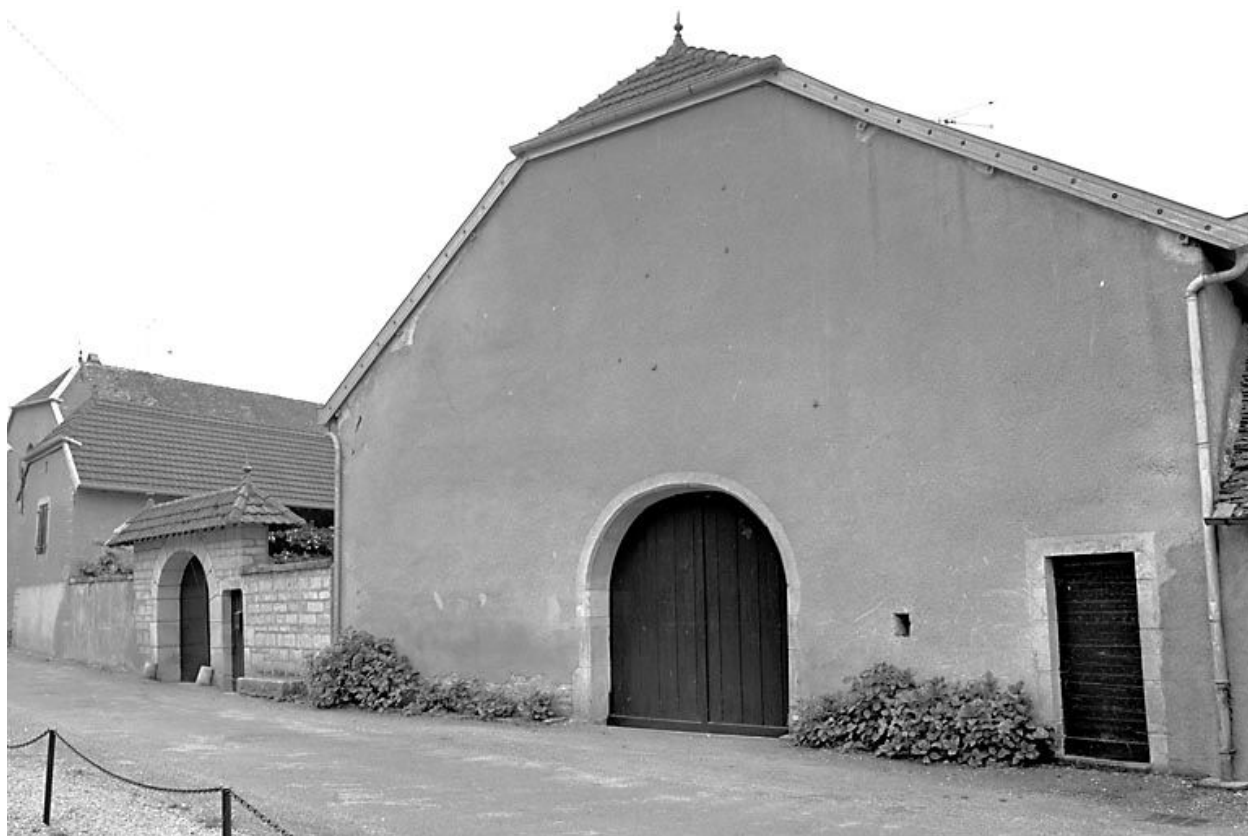
Vue d'ensemble depuis la rue.
