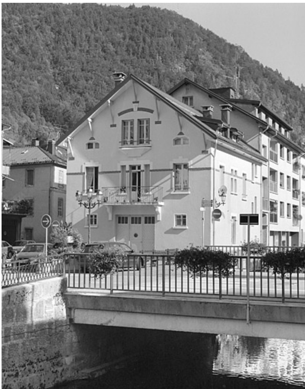
Vue d'ensemble, depuis l'ouest (cadrage vertical).
