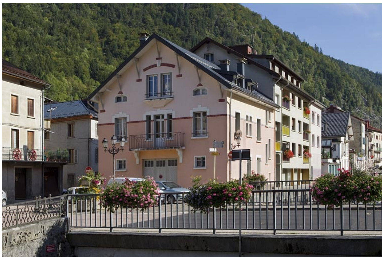
Vue d'ensemble, depuis l'ouest (cadrage horizontal).
