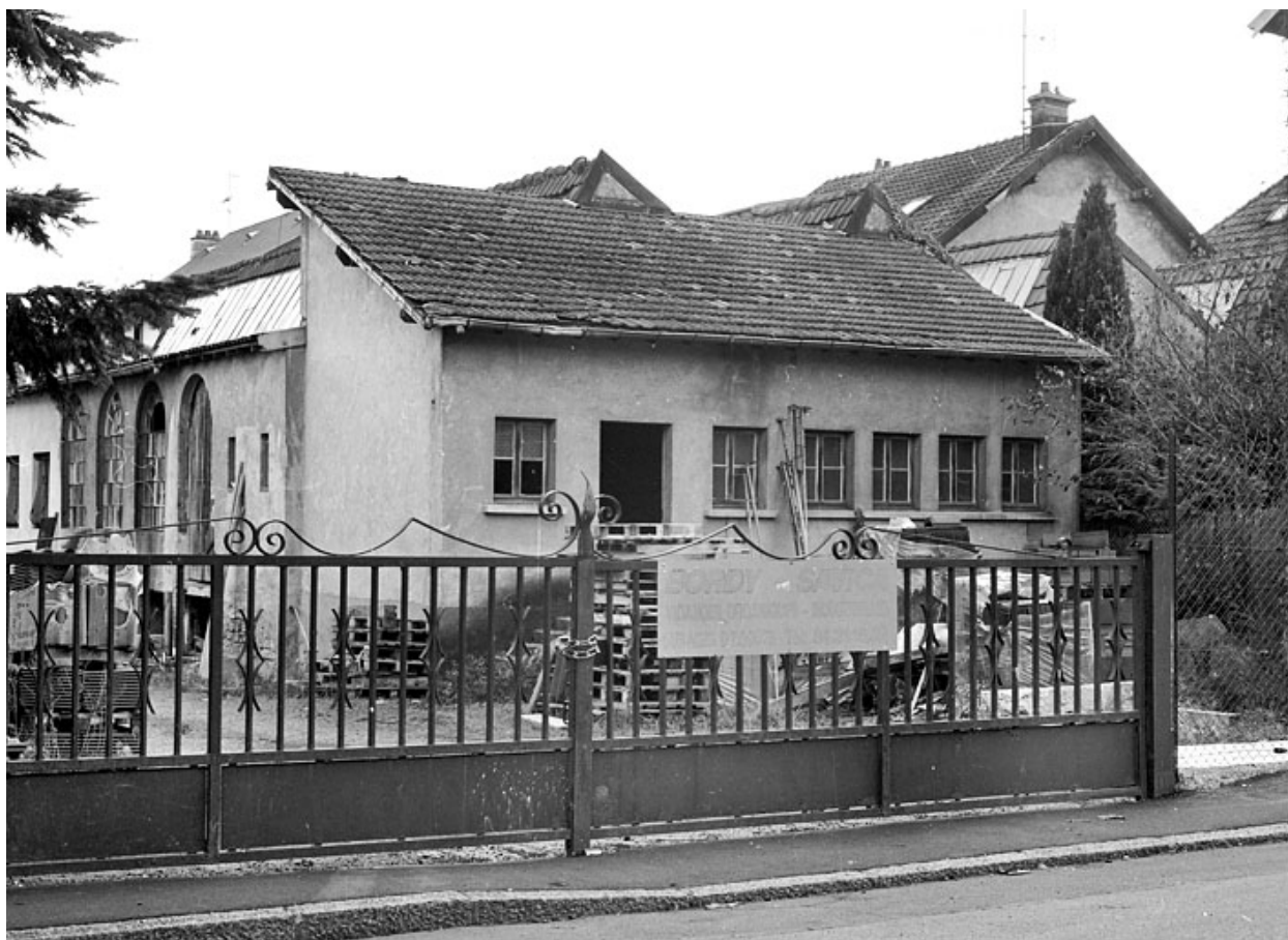
Vue arrière de l'atelier de fabrication.
