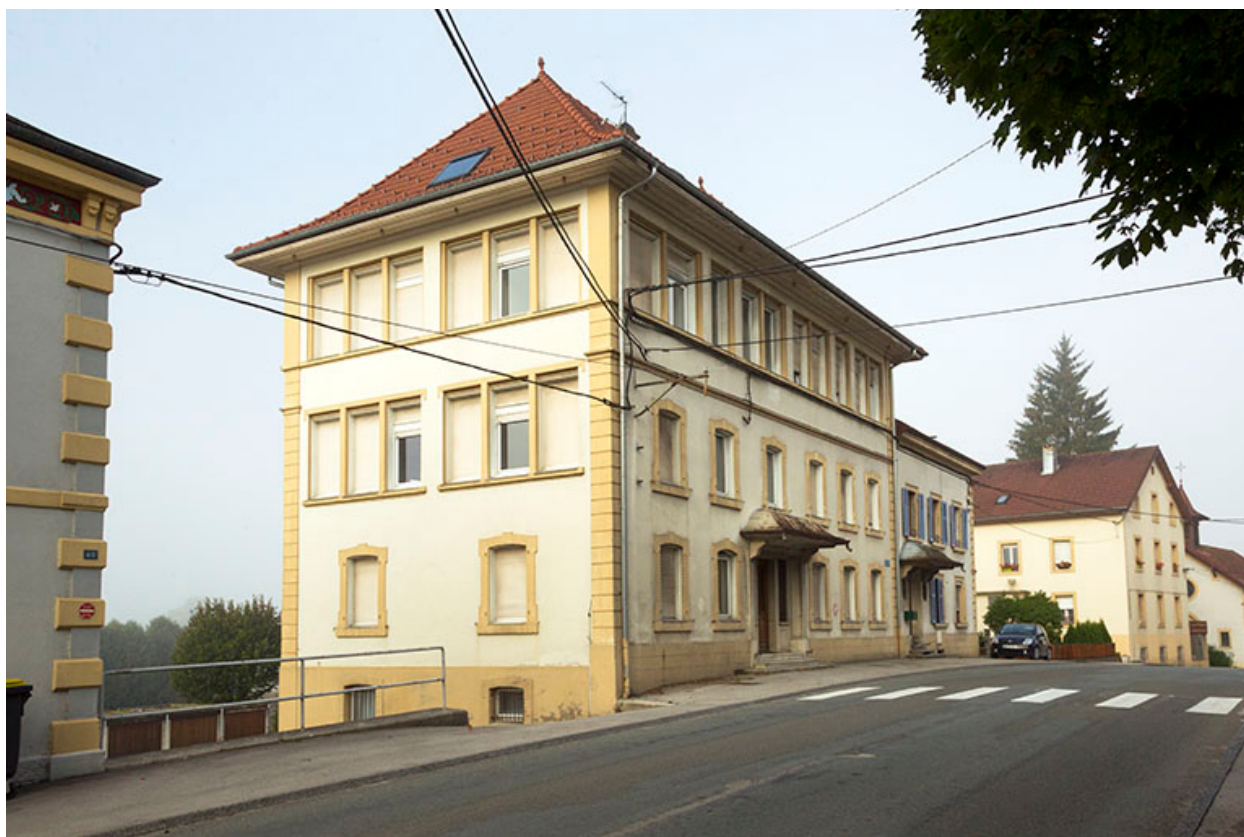
Vue d'ensemble depuis l'est (façade antérieure).
