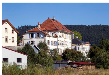
Vue d'ensemble depuis l'ouest (façade postérieure). Phot. Yves Sancey IVR43_20132502247NUC2A
