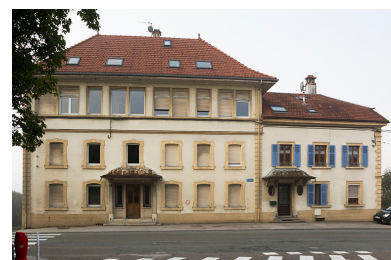
Façade antérieure. Phot. Yves Sancey IVR43_20132502248NUC2A
