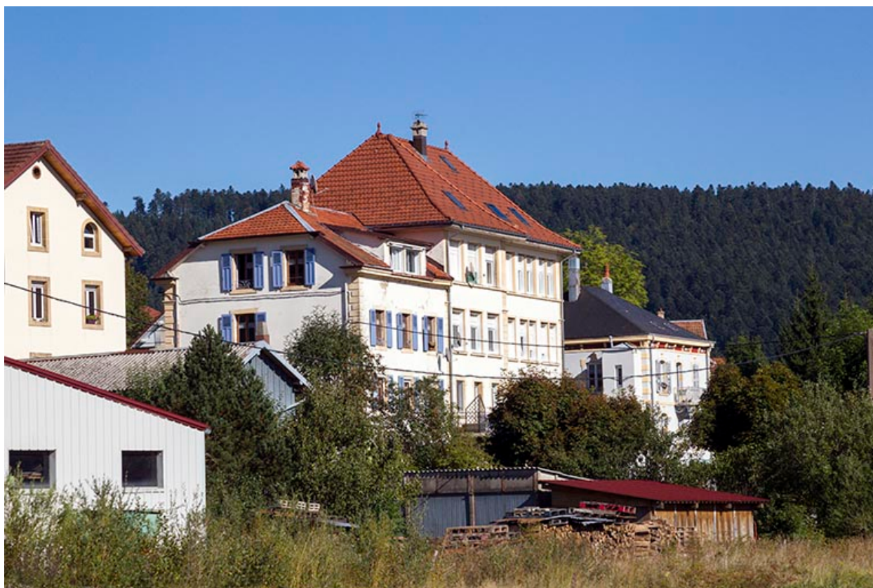
Vue d'ensemble depuis l'ouest (façade postérieure).
