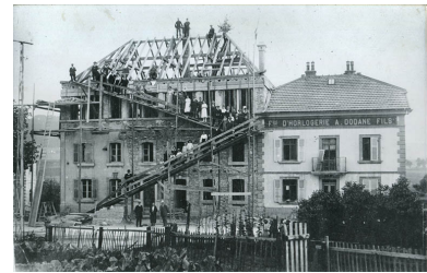
[Construction de l'usine, à l'est], années 1920 ? La maison Caille-Wetzel, incorporée à l'usine, est visible à gauche. Autr. auteur inconnu IVR43_20152500126NUC4A
