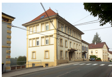
Vue d'ensemble depuis l'est (façade antérieure). Phot. Yves Sancey IVR43_20132502251NUC2A
