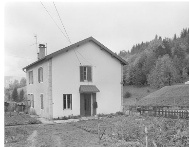
Façade postérieure et face nord-est. Phot. Jérôme Mongreville IVR43_19963901627X
