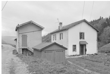
Face nord-est. Phot. Jérôme Mongreville IVR43_19963901626X
